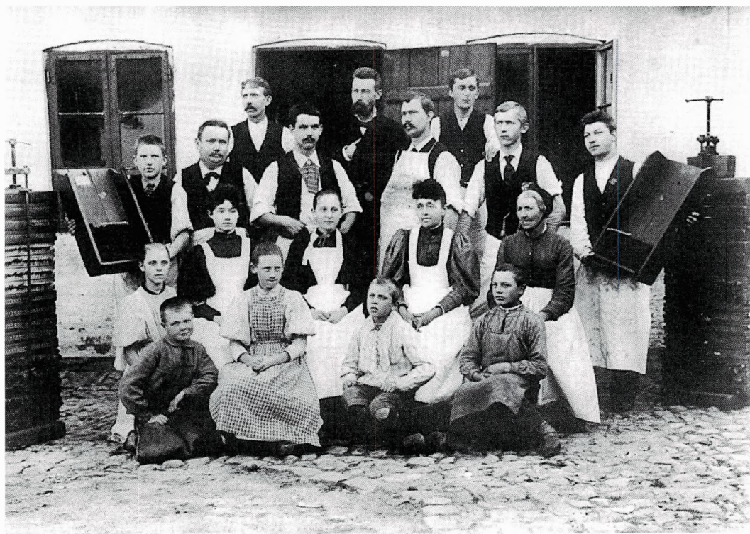
Arbejderne ved cigarfabrikken fotograferet 1893. I siderne er opstillet cigarpresser, mens lærlingene står med kasser til de færdige cigarer. Også i cigarafdelingen fandtes børnearbejdere, som fik 1,50 kr. om ugen for 4 timers dagligt arbejde. De var dog ikke så mange som i skrå- og røgtobaksafdelingen.
