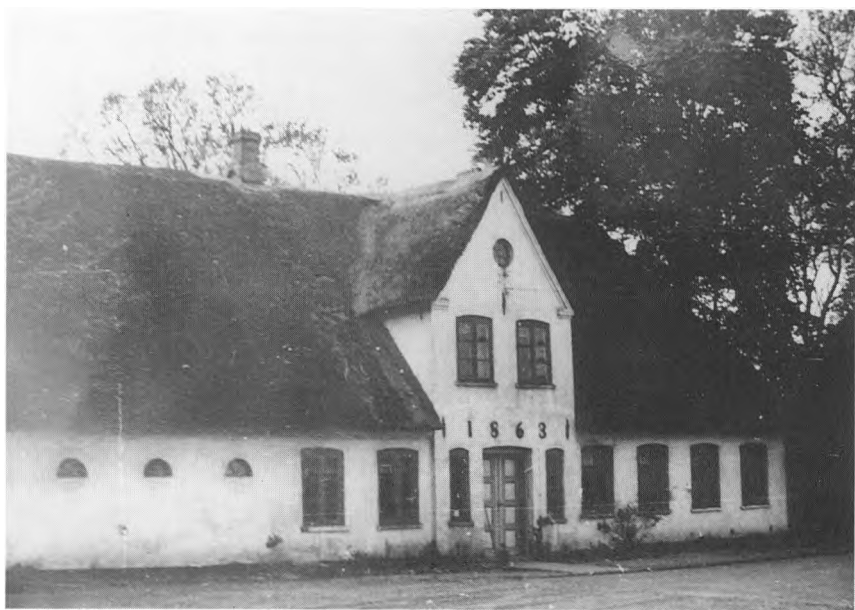
Degneboligen i Brede, der var opført 1863, blev nedbrudt 1964 for at give plads til den nye præstegård. Foruden et rummeligt stråtekt stuehus var der en mindre stald til en hest og et par køer. Bemærk de karakteristiske halvmåneformede vinduer i stalden. Historiske Samlinger for Sønderjylland.
