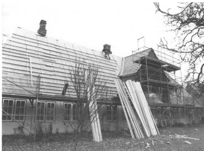
Renoveringen af museets filial Jacob Michelsens Gård begyndte i 1990 og blev i 2003 afsluttet med nylægningen af taget på hovedbygningen. Her ses håndværkerne i fuld gang med at udskifte det store tag. Foto: Aabenraa Museum.
