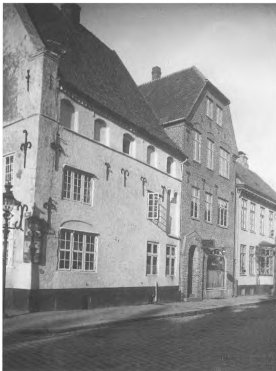
Østergade 2 A, Tønder. Beboelses- og forretnings- bygning for bager Petersen, opført 1910 af L. Thaysen. Foto 1911.
