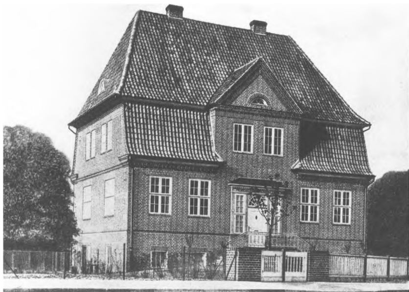
Neumünster. Villa »Marggraf«, bygget 1913 af Hans Ross. Fra: »Moderne Bauformen« 1920.
