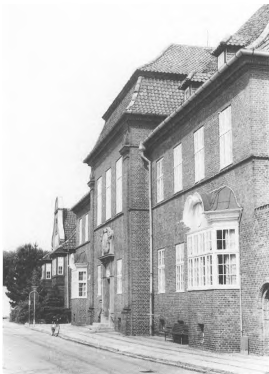
Tønder. Retsbygningen i Nørregade, bygget 1914-16 af bygningsinspektør Gyssling, Slesvig med tydelig reverens til »Digegrevens Hus«. Foto ca. 1985.
