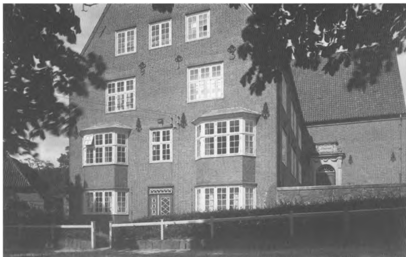
Bordesholm. Det tidligere kredshus, bygget 1912-13 af Johann Garleff, med den kar-napprydede gavlf, inspireret af gammel Tønder-byggeskik (ældre foto).
