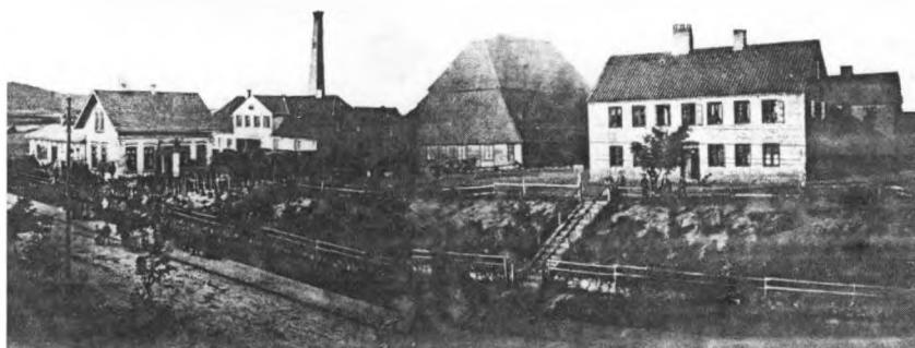
Blandt de fabrikker, som havde fremgang trods nedgangen i konjunkturerne efter 1857, var Stahnke & Jensens glasfabrik i Flensborg fra 1852, der i 1863 havde tæt ved 100 medarbejdere. Her ses fabrikken fra Aabenraagade. Foto formentlig fra 1860'erne på Museum Sønderjylland – Sønderborg Slot.
