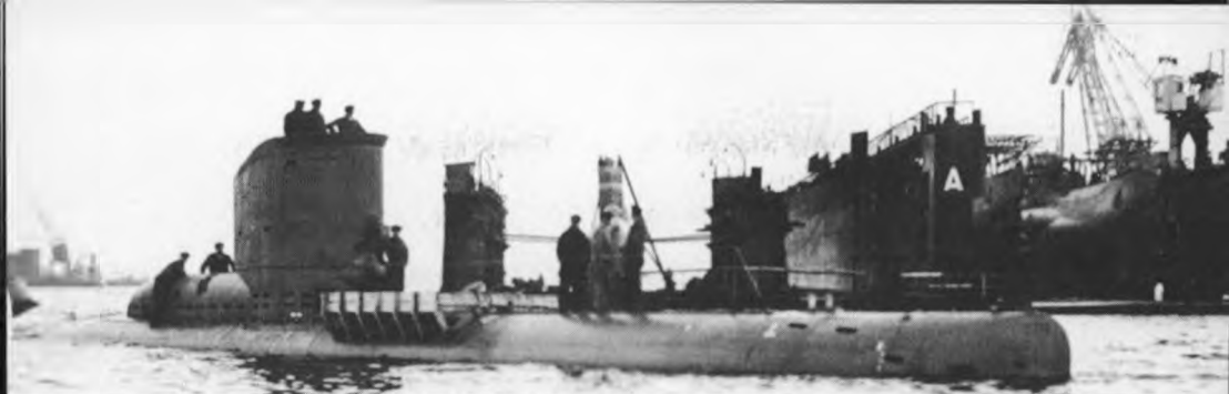
Tysk ubåd type XXIII. Længde: 34,7 m, besætning: 14 mand, totalvægt: 275 tons. En del ubåde af denne type gik ned i Hørup Hav den 5. maj 1945. De fleste i den østlige del (Lillehavet). Gengivet efter E. Rössler: Die deutschen U-Boote und ihre Werften . Bernard & Graefe, Koblenz 1990.
