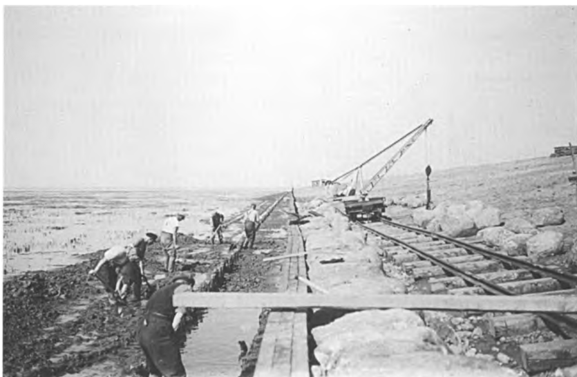
Til venstre graves klæg med håndkraft. Til højre ses en lille skinnekranvogn, der blev brugt til at lægge glacis på plads. Billedet er fra 1941-42. Foto: Museum Sønderjylland – Skærbæk.
