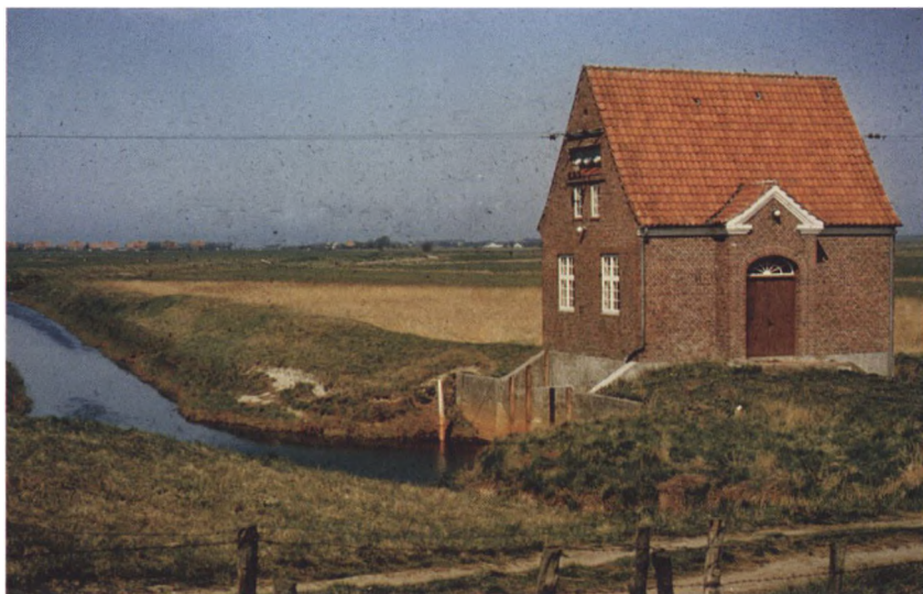
Reguleret og inddiget åløb med pumpestation i Tøndermarsken efter afvandingen i 1920'erne. Bemærk strømforbindelsen til Sønderjyllands Højspændingsværk i Aabenraa. H.P. Hansen foreslog, at strømmen blev købt her i stedet for at oprette et vandkraftværk. Foto: Museum Sønderjylland – ISL.
