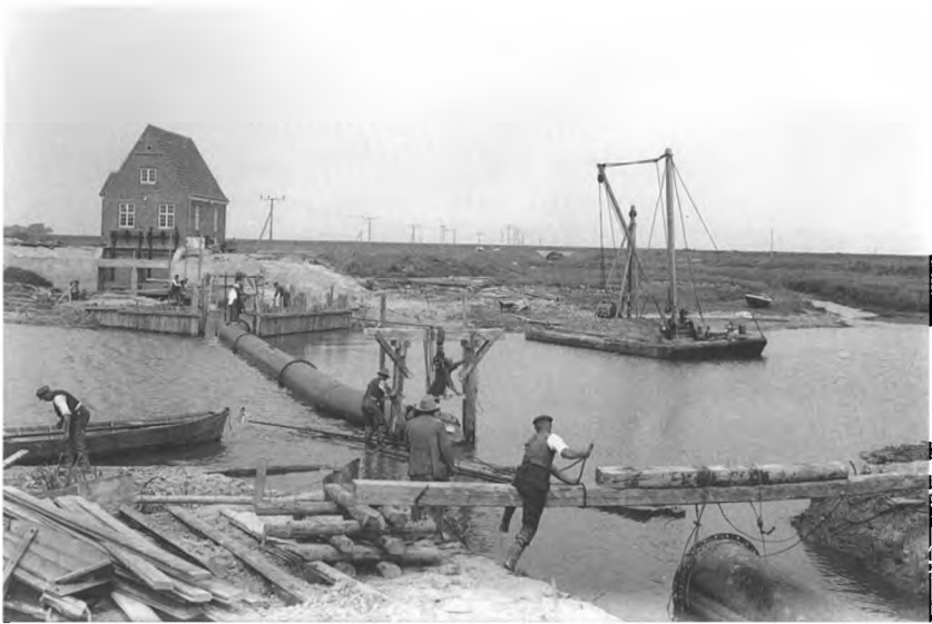
Etablering af pumpestation ved Højer i forbindelse med Tøndermarskens afvanding 1927-1933. Billedet er fra 1929. Foto: Fiskeri- og Søfartsmuseet i Esbjerg.
