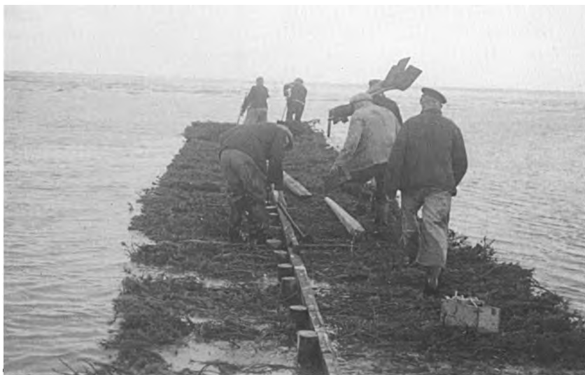
Tippen« – dæmningens forreste arbejdsplads. Her lægges der faskinmætter (granris) ud som underlag for dæmningsfyldet. Billedet er fra 1940. Foto: Museum Sønderjylland – Skærbæk.
