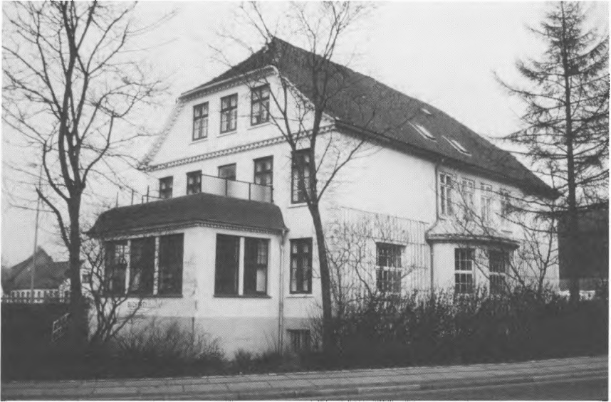
Det industrielle miljø i Sønderborg 1875–1914 kendetegnedes ved, at industri og boliger var nært forbundet i byplanen. Mest karakteristisk var i så henseende eksportbryggeriet. Den store bryggervilla lå ikke langt fra de nu forsvundne produktionsbygninger. Også en stor del af arbejdsstyrken, der i 1906 var på sit højeste med 53 mand, havde boliger ved virksomheden i arbejderhuse opført og ejet af brygger Petersen. Bryggeriet udgjorde dermed et lille kvarter for sig. Fot. 1982 fra diasserie i Museet på Sønderborg Slot.
