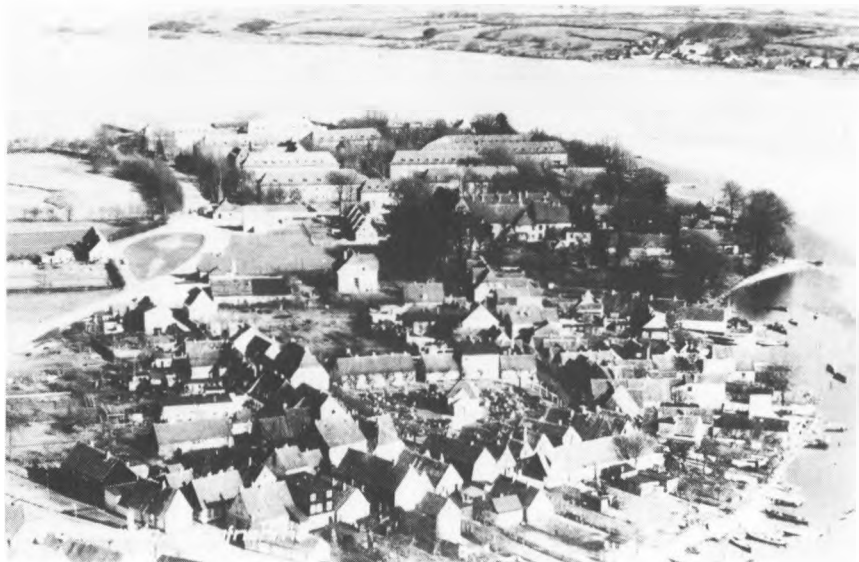
Fiskerlejet Holmen ved Slesvig foran, og kasernen Die Freiheit bagved i billedet. Kasernen blev bygget på holmernes tidligere nettørreplads Friheden. Fra 1939–1940.
