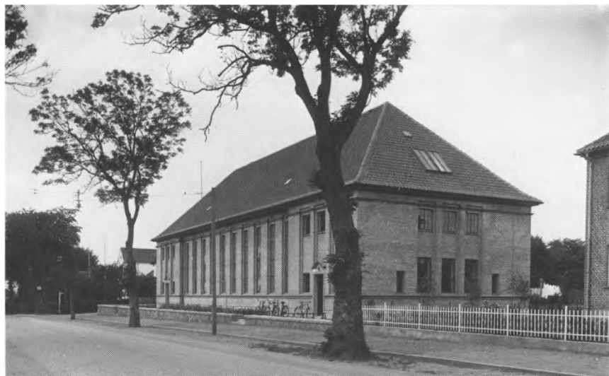
Den 28. april 1931 stadfæstede kongen loven om oprettelsen af »Landsarkivet for de sønderjyske Landsdele«, men der gik over et år, før byggeriet kom igang. Aabenraa by skænkede en grund i den nordlige udkant af byen ved landevejen til Haderslev, og kgl. bygningsinspektør K. Lehn Petersen, Odense, udarbejdede tegningen til bygningen, hvis indretning bar præg af, at der var udvist den største sparsommelighed. Der var således ingen bolig for landsarkivaren som ved de andre landsarkiver - kun arkivbetjenten fik bolig i bygningen. Fot. Det kongelige Bibliotek.
