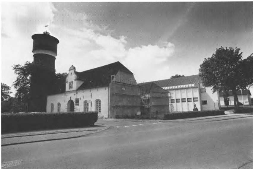
Museerne i Tønders bygningsanlæg blev i 1988 udvidet med det nedlagte vandtårn fra 1902.
