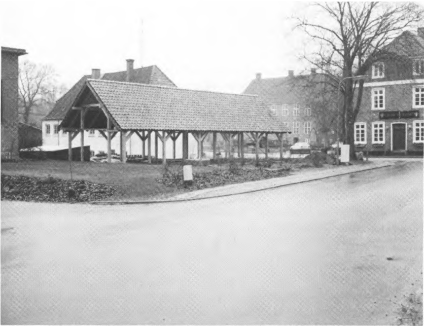
Hvalhuset, som det så ud i marts 1989, efter at de fleste af de donerede penge var brugt.
