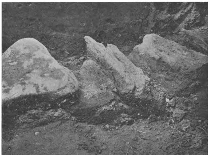
Fundamentet til Vardehus.
