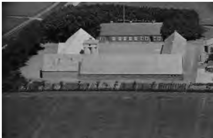
Abildgård: AAL_BLI2-A1_079_05: 1948-52 Siloerne kan være opført efter 1945
