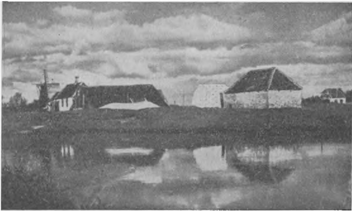
Fig. 4. Muremester Hansens Kalkovn ved Pramstedet ved Varde Aa. Den hvide Bygning med Trækkanalerne er selve Ovn. Foran staar et Oplagsrum til Klyne og den brændte Kalk; til venstre ses Fisker Chr. Muffs Hus og foran det en Dyngte Skæl.
