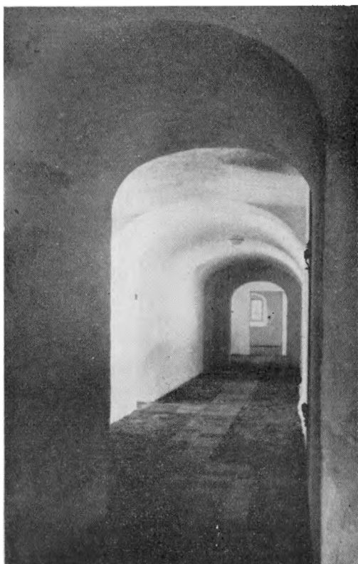
Kældergang i Sydfløjen, set fra Hovedbygningen.
