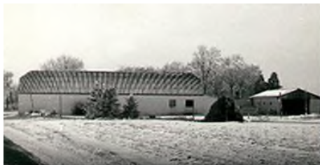
Forældrenes ejendom Sandhus på Tyvkærvej, Isenvad, her startede Ikast Byggeindustri 1972.
