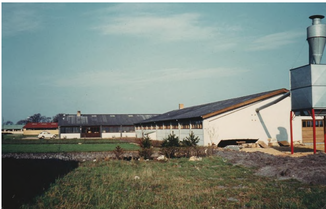
Maskinværkstedet set fra øst.
