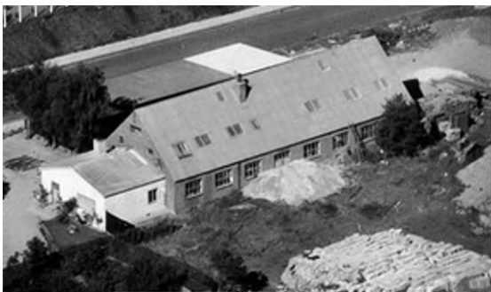
Ikast Møbelfabrik bygget 1946 (KB: Danmark set fra luften)
