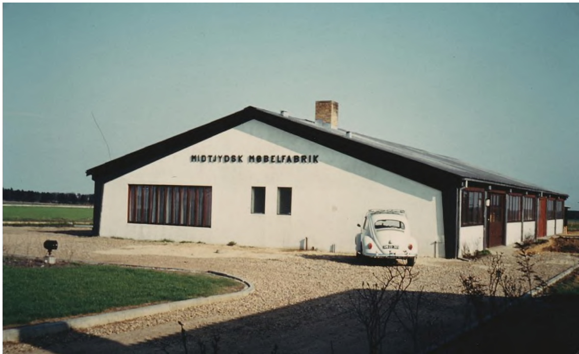
Den første hal, der blev opført på Eli Christensens Vej. Samleværkstedet.
