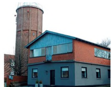
Peder Skjærbæks hus, Sverigesgade
