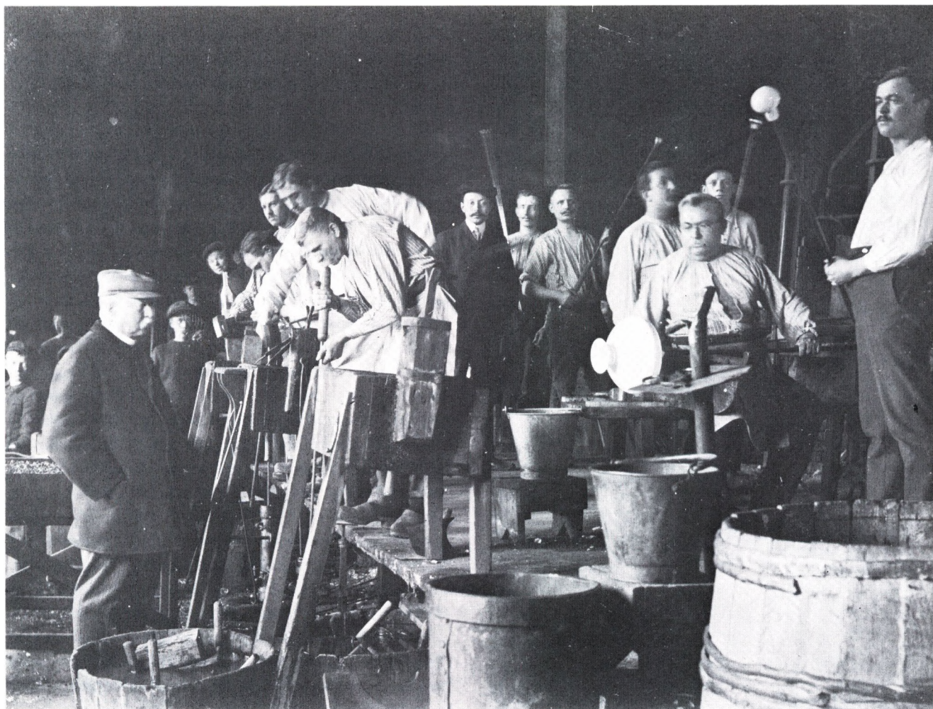
Billedet fra glasværket er formentlig fra omkring 1910 og viser nogle af de forskellige faser i glasfremstillingen. Mange af glasmagerne var indvandret fra Tyskland, således også hyttimesteren, der står til venstre i billedet (med kasket).
