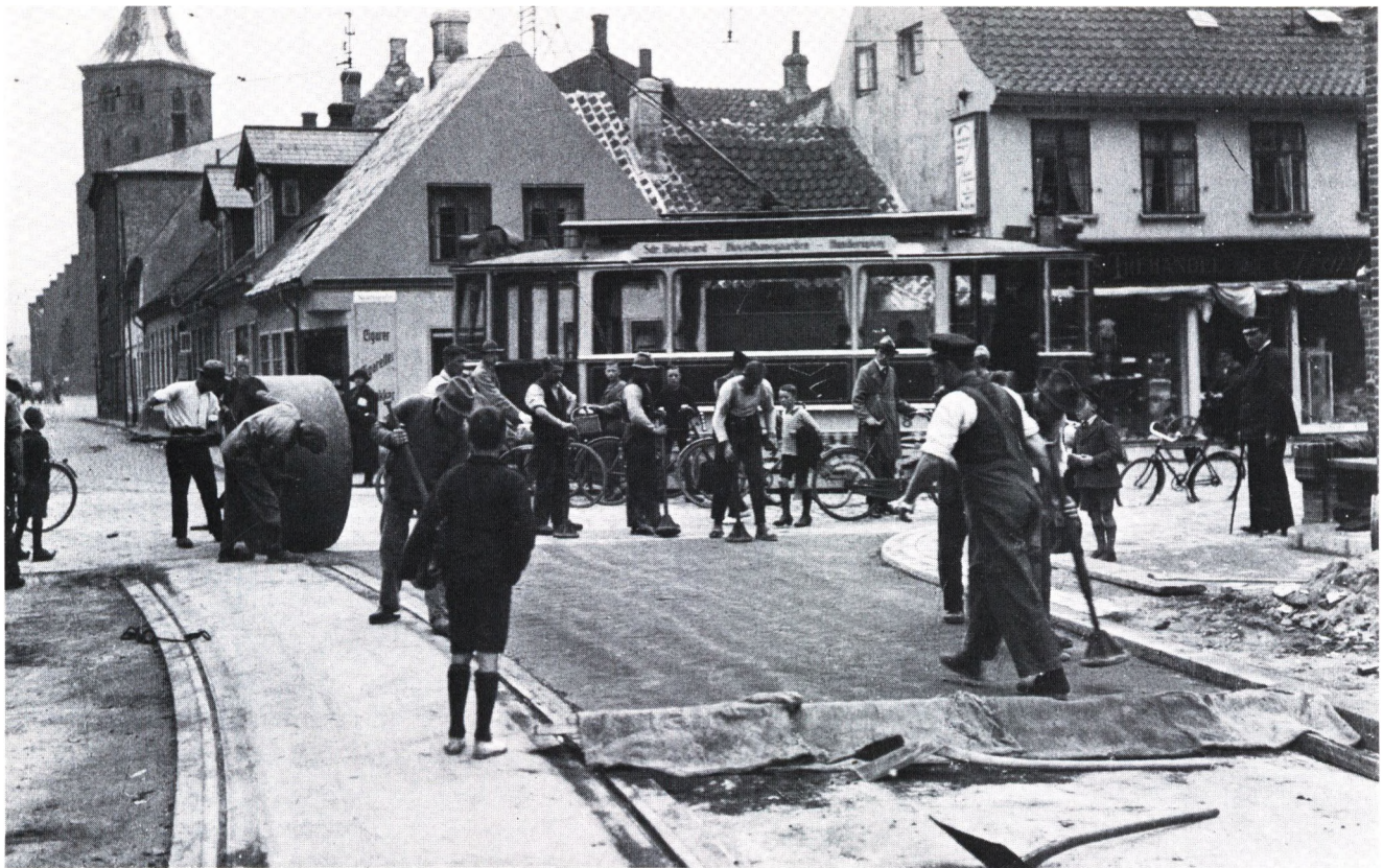
Mageløs blev brudt igennem til Kongensgade, og der blev lagt sporvognsskiner her, men de kom aldrig i brug. 1925.
