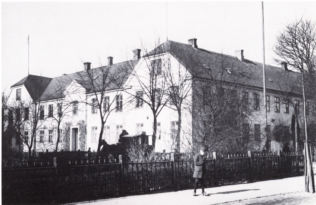
Fattiggården i Vindegade, set fra Klostervej omkring 1912. Tre år senere flyttedes fattiggården til sygehusbygningerne i Albanigade. (Herluf Lykke fot., Møntergården).
