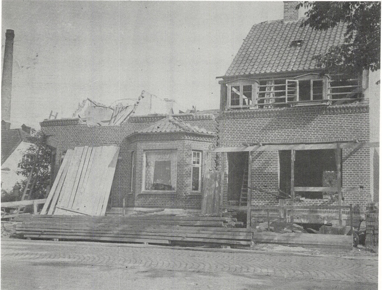
Efter at tilbygningen til det oprindelige hus var foretaget, blev tagetagen på dette nedrevet, og det færdige hus ses side 20
