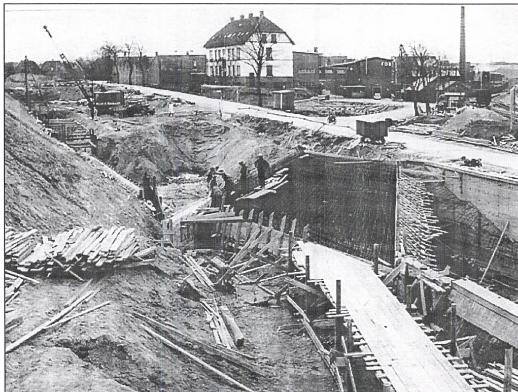
I 1955 var man i færd med at støbe broen, der skulle føre Enghavevej over Gammel Horsens Landevej (Holme Ringvej). Mellem broen og FDBs fabrikker går den gamle vej. FDBs fabrikker ses i den gennem mange år kendte skikkelse, og den gamle Viby station skimtes bag allétræerne.
