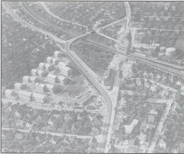
Jernbaneviadukterne i Kongsvang. Den gamle bro med svingene fra 1916/17 og den nye bro med den lige landevej under byggeri i 1953.
