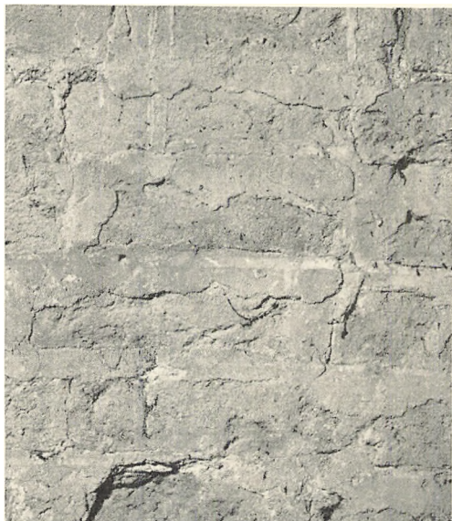
Fig. 9—10. Søborg. 9. Rødkalket murværk med hvidmalede fuger på triumfvæggens vestside, over hvælv (p. 1101). 10. Søborg . Skitseopmåling af murrester m.v. i skibets vestre ende. C. G. Schultz 1939 (p. 1108).
