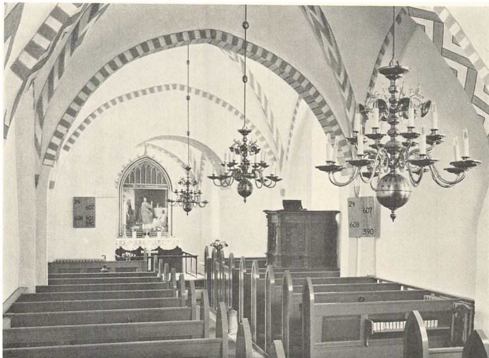
Fig. 12. Valby. Indre, set mod øst. (Under restaurering 1969).
