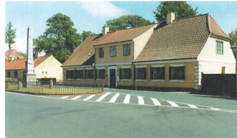
■ Hørsholm Egnsmuseums bygninger 2005.
