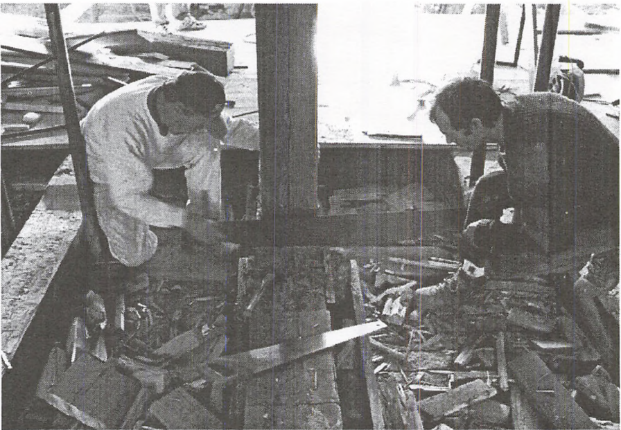
Gulvet sænkes på de lave lofter i Sukkerhuset. Foto Flemming G. Rasmussen.
