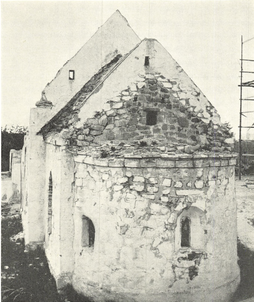
Fig. 5. Øster Marie. Den gamle kirke under nedbrydning, set fra øst.
