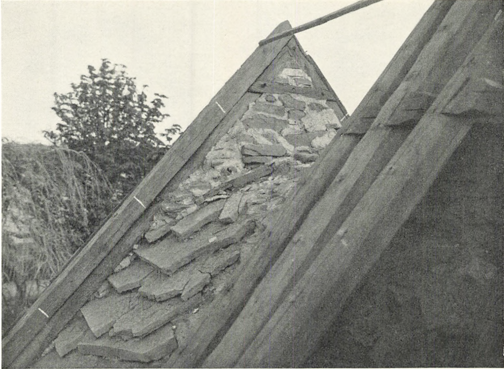
Fig. 4. S. Knuds kirke. Nordsiden af korets oprindelige tag af silurkalkflager som det så ud, da det blev opdaget ved tagværkets omsætning i 1913. Afstandene mellem de 3 hvide streger på gavlsparret er 1 m.
