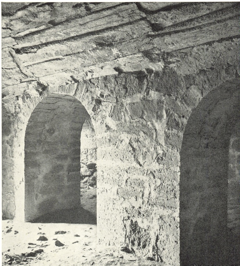
Fig. 6. S. Ibs kirke. Detalje af hvælvningssystemet i tårnets 2. etage. I kalken foroven ses aftryk af den bræddeforskalling, hvorover tøndehvælvet er støbt.
