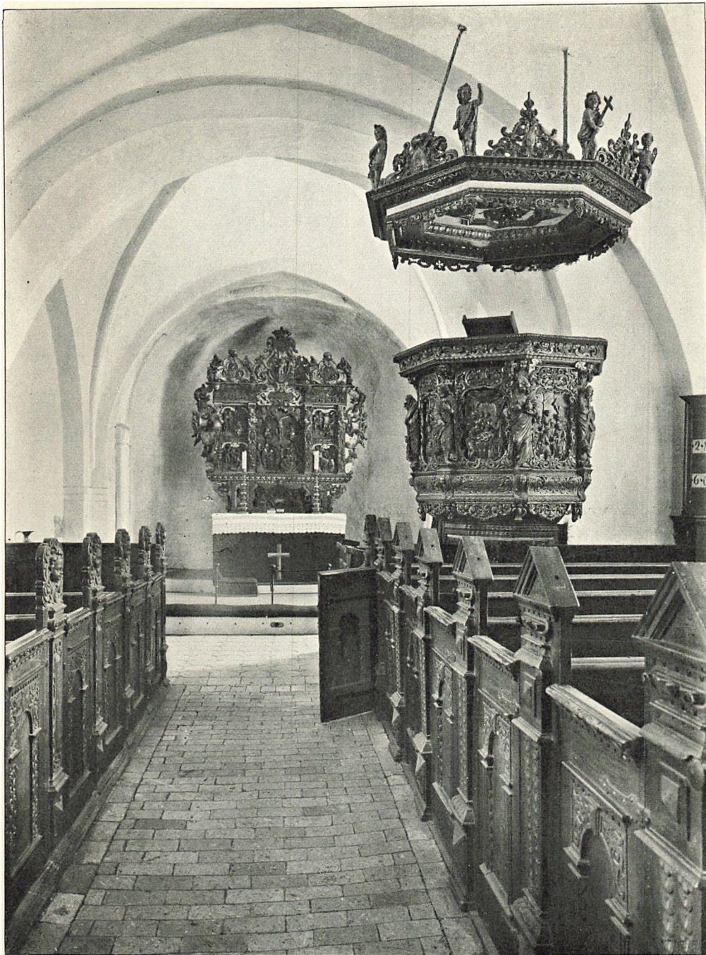
Fig. 7. Hammer. Indre, set mod Ost.
