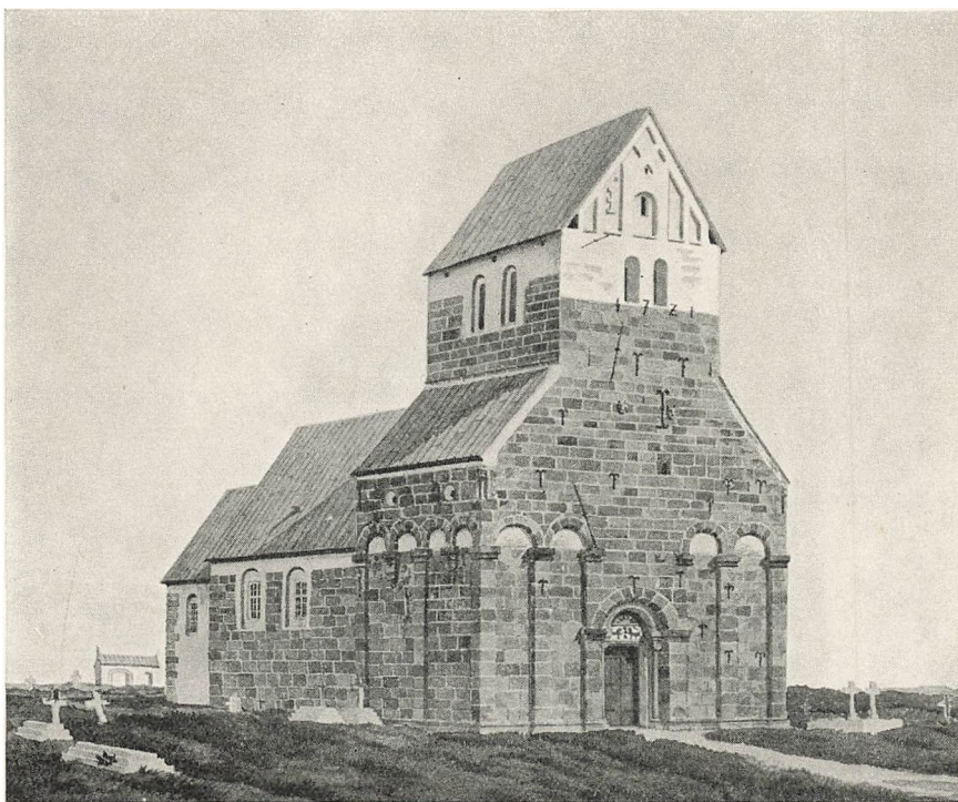
Fig. 24. Hee Kirke før Restaureringen.
