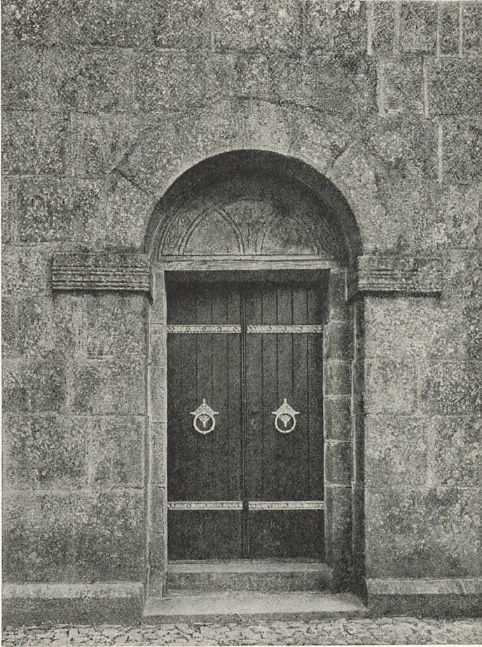
Fig. 50. Portal fra Hvirring Kirke.
