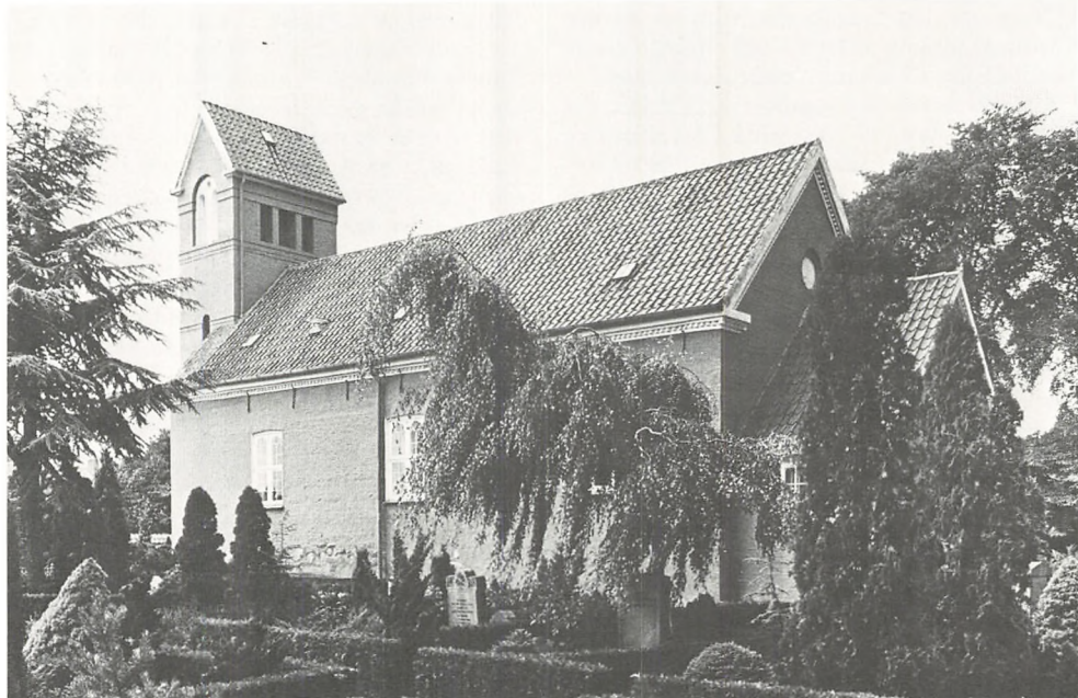
Rødovre Kirke set fra nordøst; de store kampesten i muren er fra en tidligere kirke.
