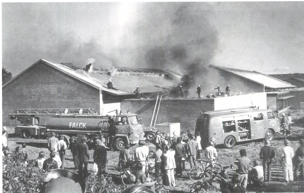
Branden på Hasle Skole 15. Juni 1973. Forrest ses Falcks Scania tankvogn vogn 3619 – en brugt Esso-tankvogn, der var blevet sat i drift kort tid forinden. (Foto: Århus Stiftstidendes billedtjeneste)
