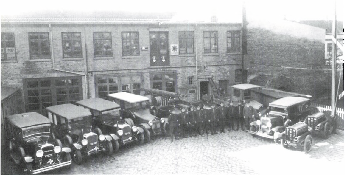
Falcks vognpark og station i Nørre Allé ca. 1930. Bagest til højre ses den lastvogn, der efter overflytning fra Falcks entreprenøraftdeling i København blev monteret med kran. Bygningen i Nørre Allé findes stadig og ejes af KFUM. Den er dog ombygget adskillige gange, og det er i dag vanskeligt at kende træk i bygningen fra den tid, den husede Falcks station (Foto i privateje).
