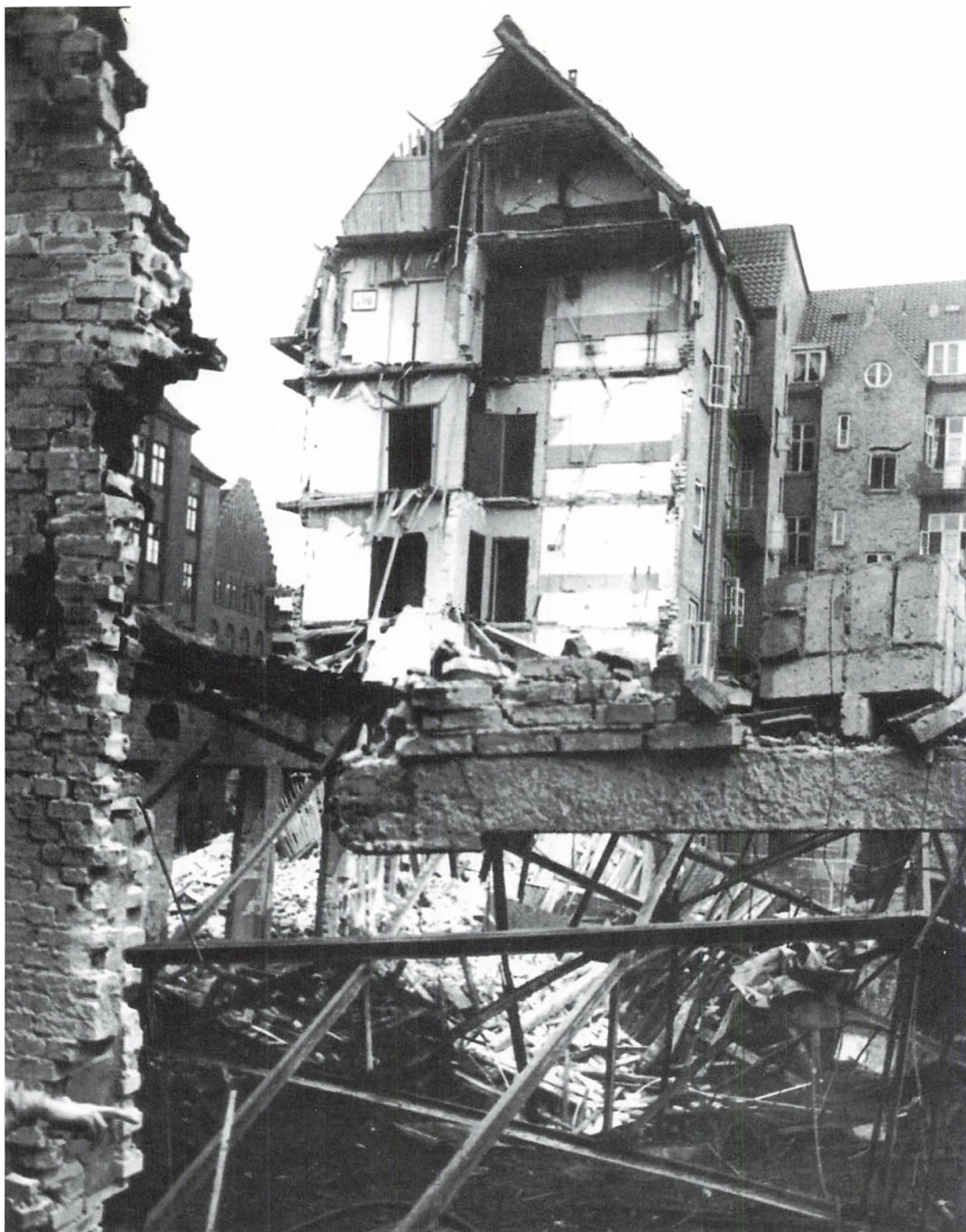
Ejendommen Sct. Knuds Gade 3 efter schalburgtøgen mod Århus Hallen. Fem mennesker omkom, da halvdelen af ejendommen styrtede sammen, men to kvinder, der overnattede i lejligheden på fjerde sal overlevede mirakuløst. (Foto i privateje)
