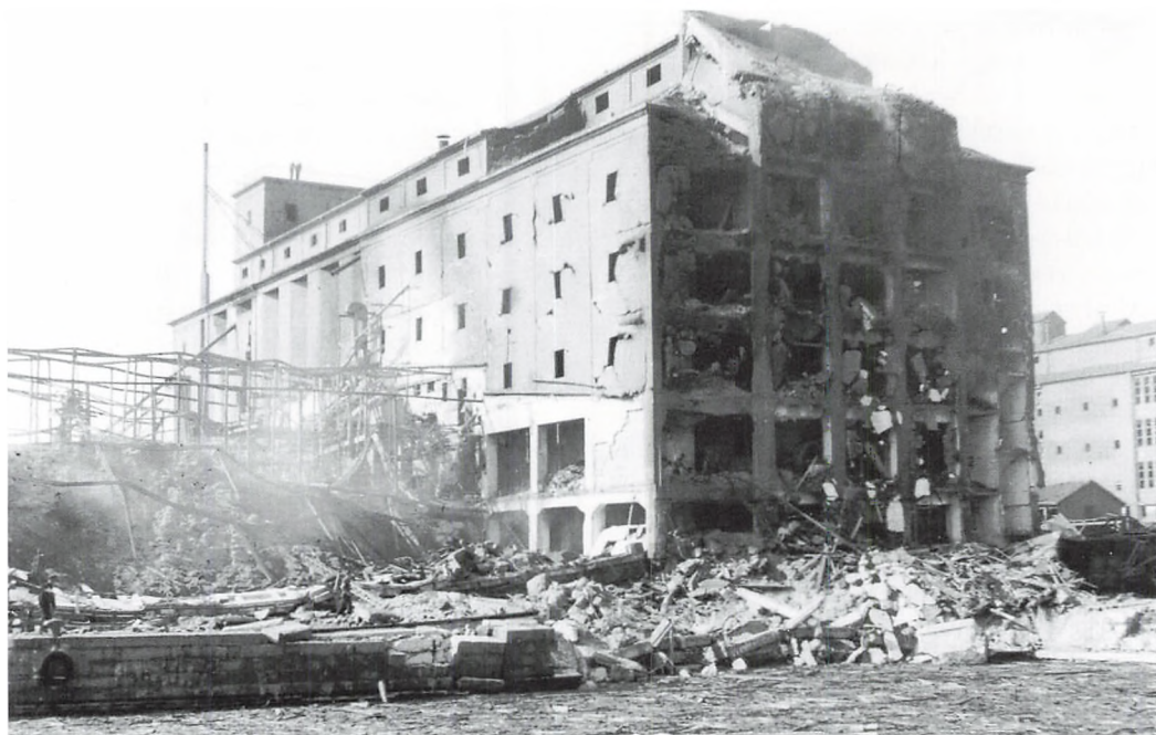
4. juli-ulykken anrettede voldsomme ødelæggelser på Århus Havn. Blandt de hårdt ramte bygninger var KFK's silo, som fik blæst gavlen ind. Adskillige arbejdere blev reddet fra den brændende silo under stor risiko for redningsfolkene. (Foto i Lokalhistorisk Samling)
