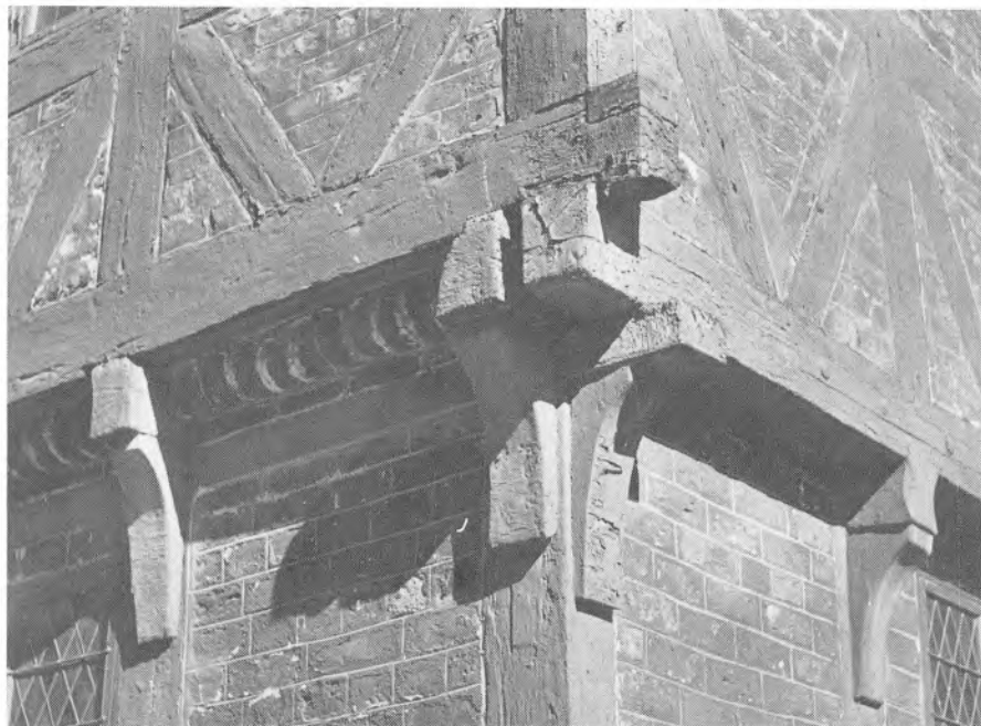
Aalborggården. Trestokværkshuset. Hjørnekonstruktion (efter flytningen til »Den gamle By«). Billedet viser den klare konstruktive sammensøjning af langsiden og gavlens tømmerstykker (gavlen til højre). Forf. fot.
