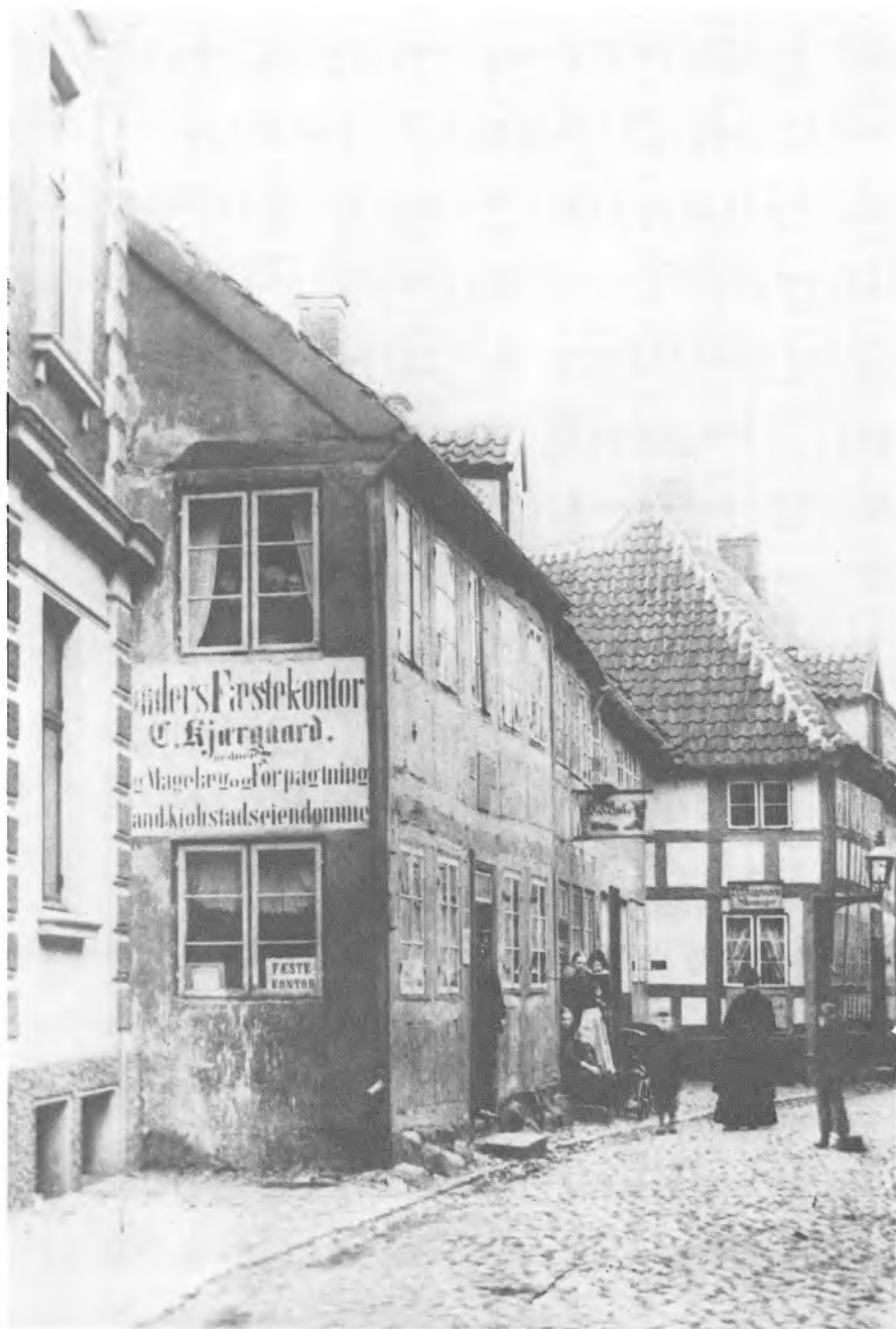
Provstegade 6 i Randers, opført ca. 1650 (opr. sammenhørende med nr. 8). Ældre fot.
