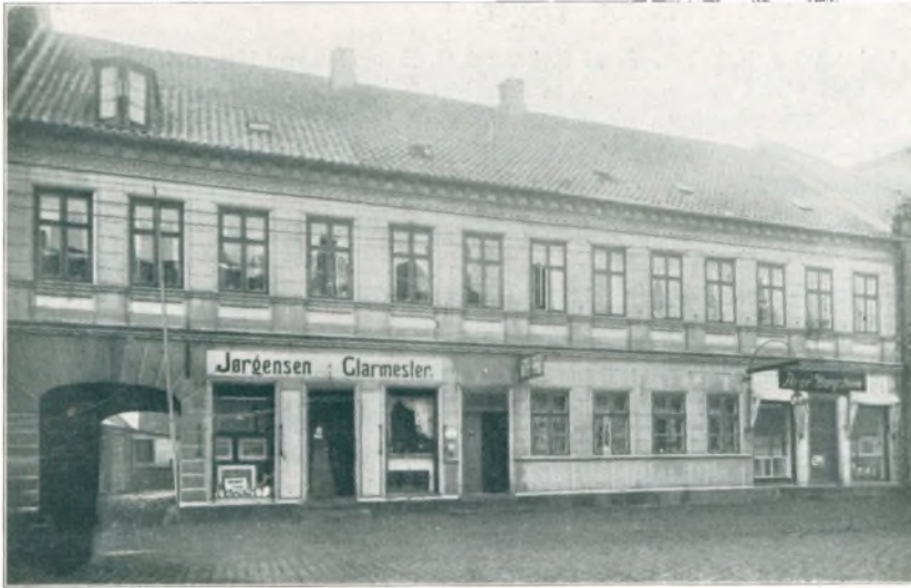
Bageriet før Ombygningen.
