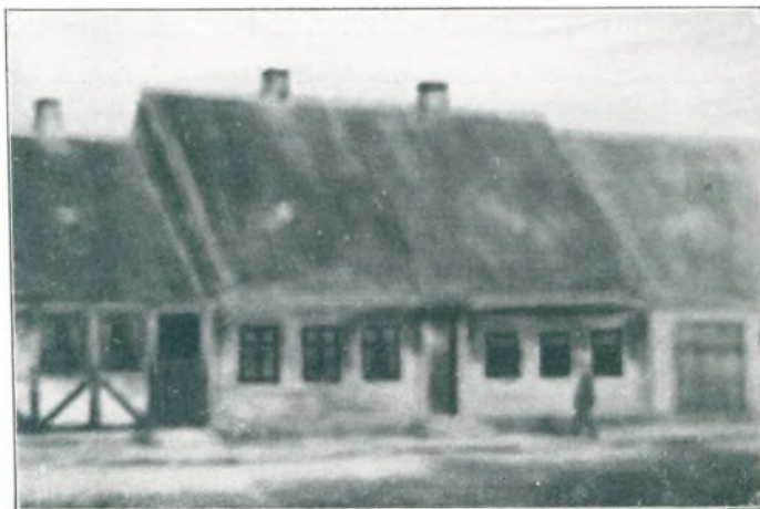
Bankens Lokale 1857 i Løvegade.
