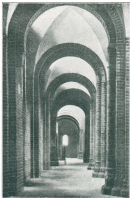
Nordre Sideskib, set mod Øst, efter Restaureringen.
