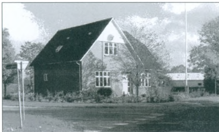
Som den gamle stationsbygning ser ud i dag.
