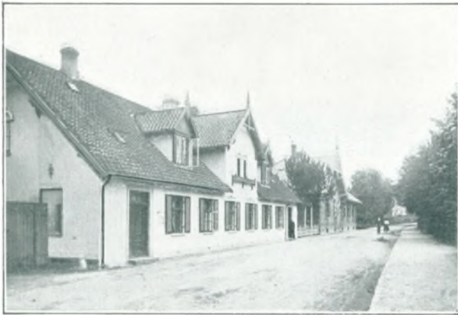
Kong Frederik VII Staldbygninger ved Skodsborg, Sanatoriets første Kurhus og Kontorer.
