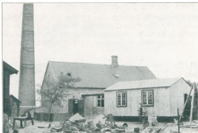
Pumpestationen ved Aagerup Værket.
