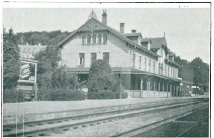
Klampenborg Station, Hovedbygningen.
