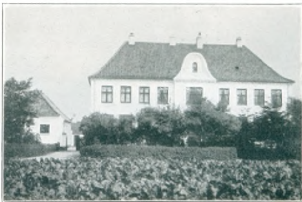
Herstedøster ny Skole, bygget 1914.
