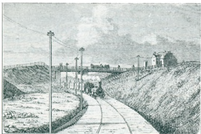
Viadukten ved Frederiksdalsvej.
