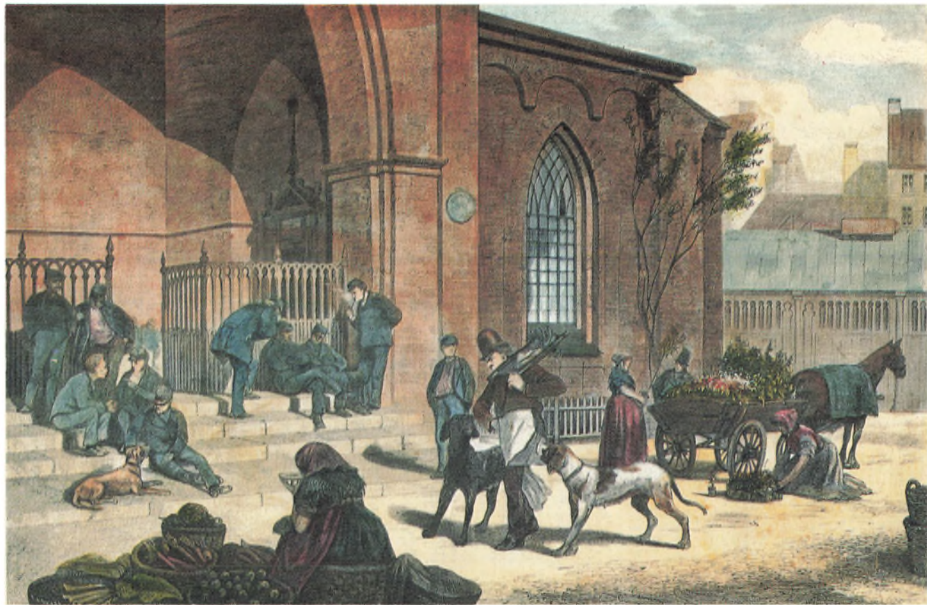
Hovedbrandstationen i Nicolai Kirke
