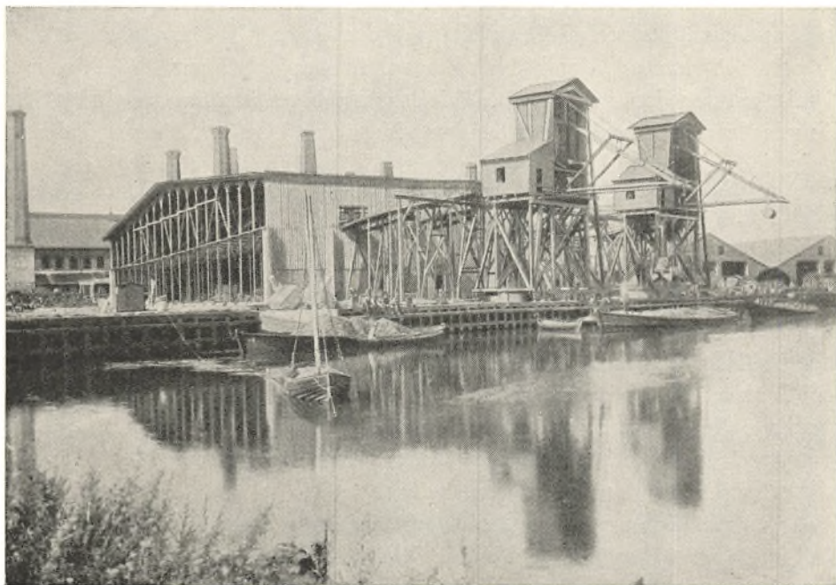
De to Hunt'ske Elevatorer ved Vestre Gasværk.
