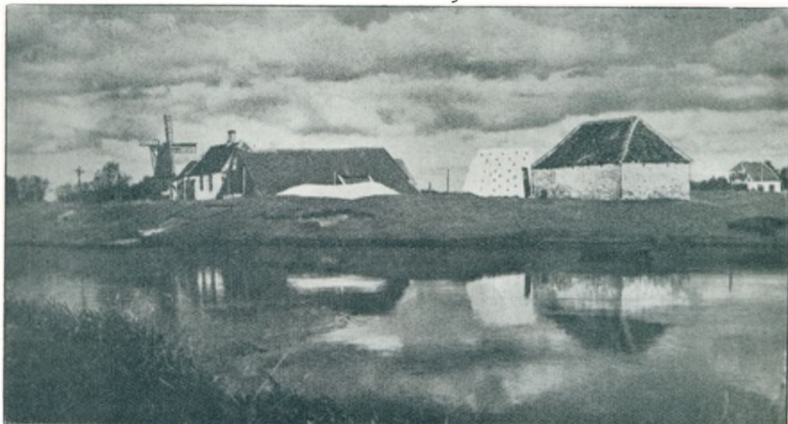
Kalkovnen ved Varde (nu forsvunden).
