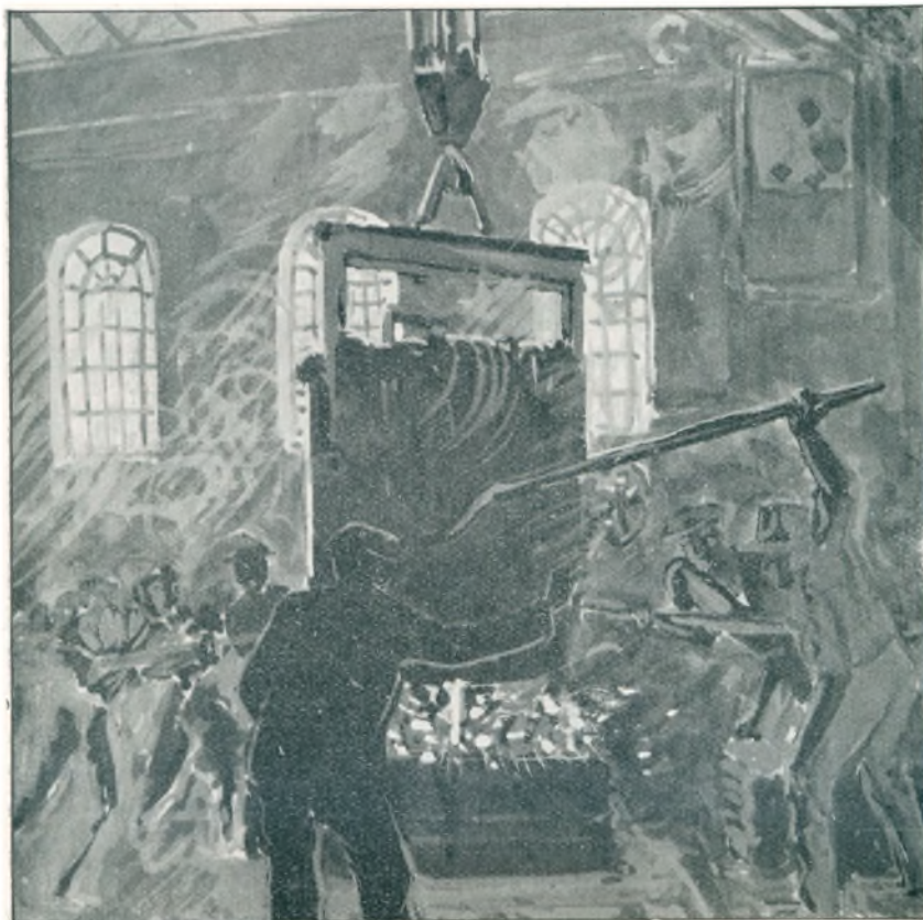
Støbning paa Varde Staalværk.
