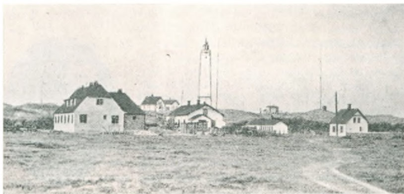
Blaavand Fyr- og Radiostation.
