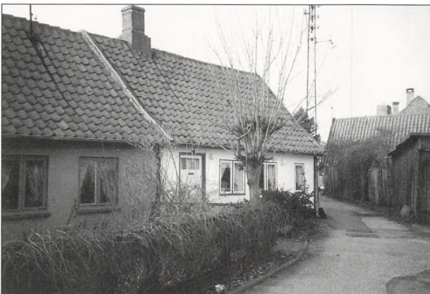
Skyllebakkegade 7. (Foto: Forfatteren, 1994)
