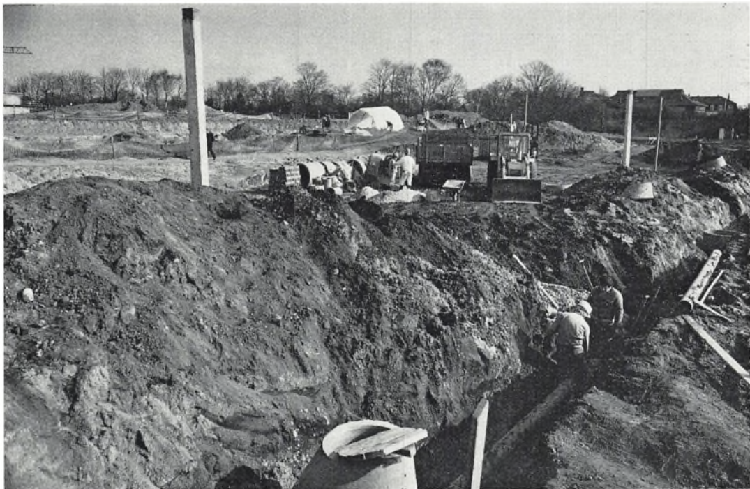
105 Byggemodningsarbejde på terrænet neden for Vedbæk station marts 1975
