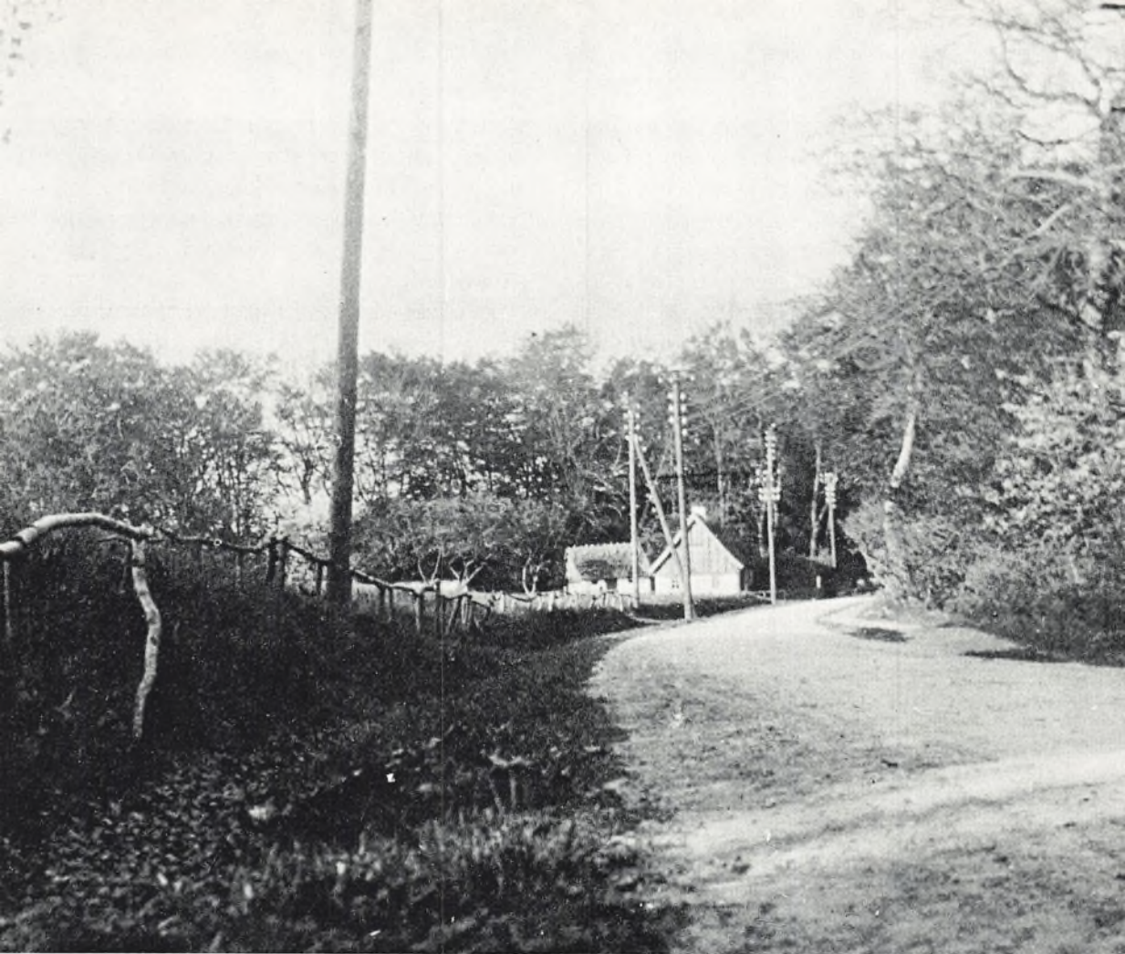
63 Trørød Hegns gamle østre skovløbersted fot. o. 1900, endnu i ensom idyl. Bag huset frugthave med bistader på række. Langs vejen hen til Skovholmen, hvor fotografen står, den primitivt indhegnede skovløberjord, som kommunen allerede har fået kig på til nyt skolebyggeri
