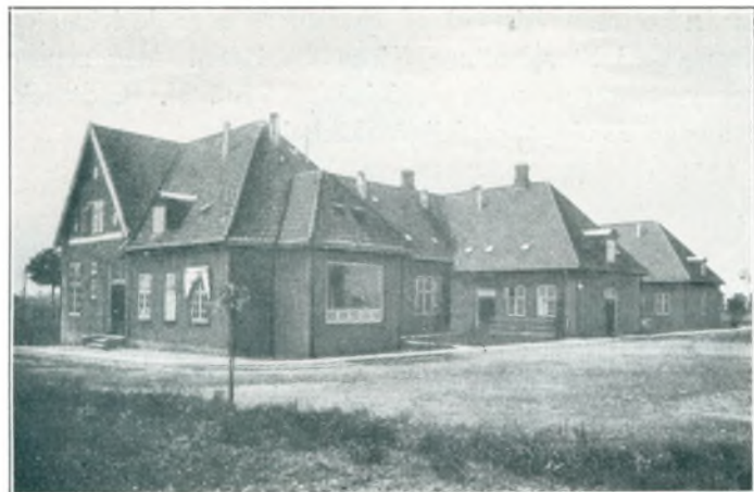
Udbygningerne bag Hovedbygningen.
