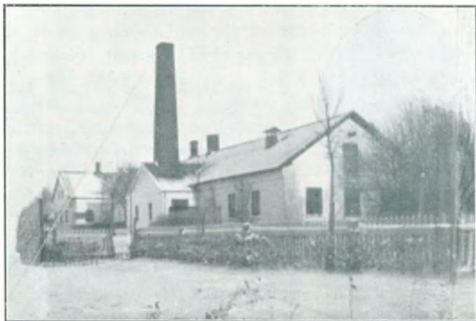
Andelsbageriet „Syd Stevns“.
