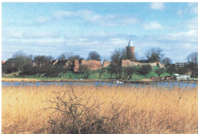
Vordingborg fra syd. De bedst bevarede mure indgår i centralborgens sydmur.
