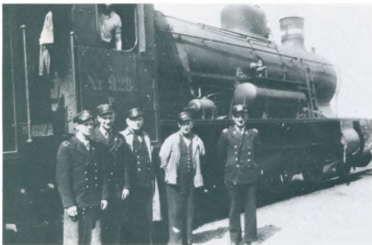
Man nåede aldrig at få alle de jyske lokomotiver forsynet med panserplader. P 928, som her holder i Padborg, har fået panserplader på siden af førerhuset, men de store sidevinduer og frontpartiet kan man naturligvis ikke dække, og det var også her, de fleste projektiler gik ind under angrebene. Lokomotivfolkene uniformer er luvslidte, og arbejdsjakken laset. Billedet er taget få dage før krigens ophør. (Foto: Arkiv E.J. Hellesten)
