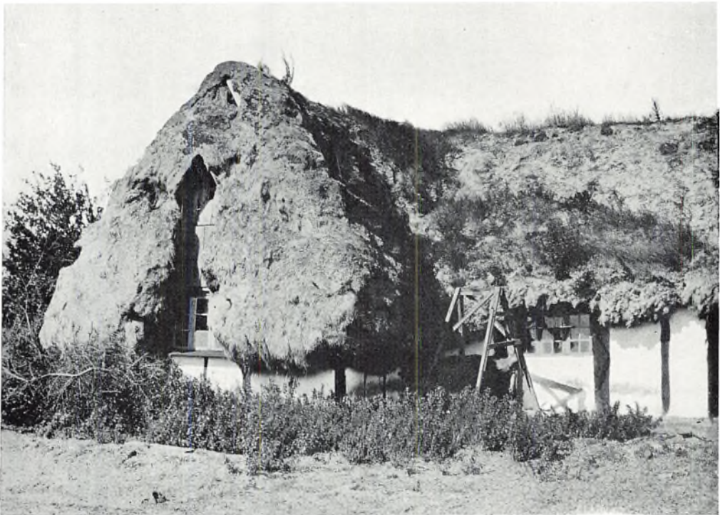
LÆSØ. Den østre gavl af Juelsmindes stuehus. Bemærk udskæringen i tangtaget til vinduerne. (388)
