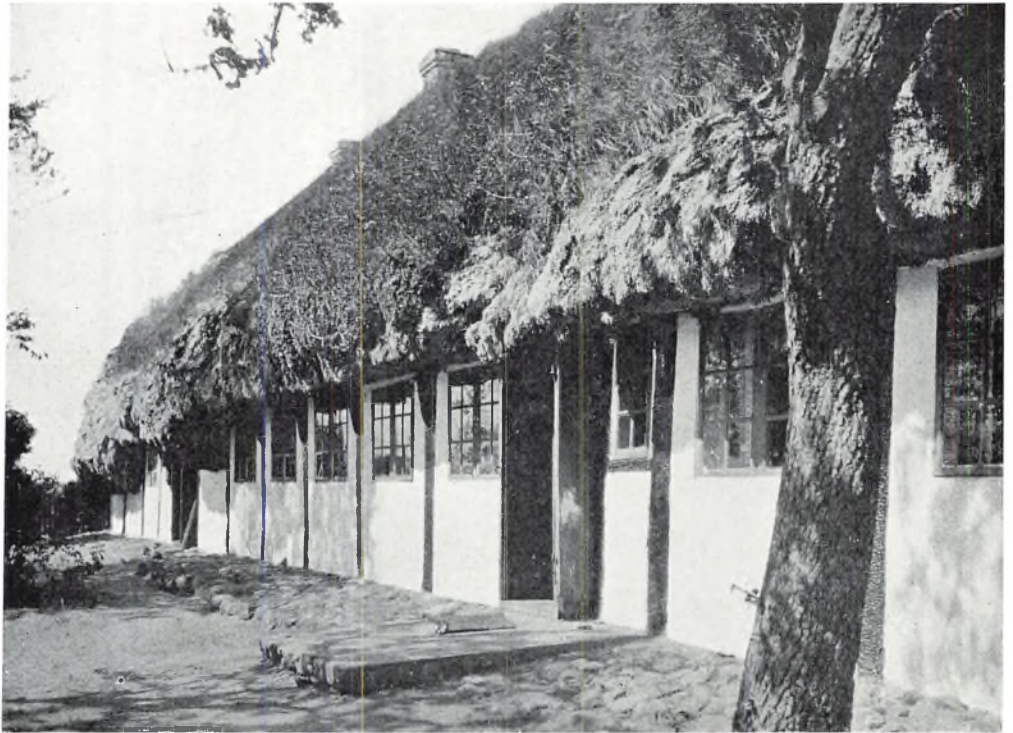
LÆSØ. Juelsminde's stuehus. Facade mod haven i syd. (388)
