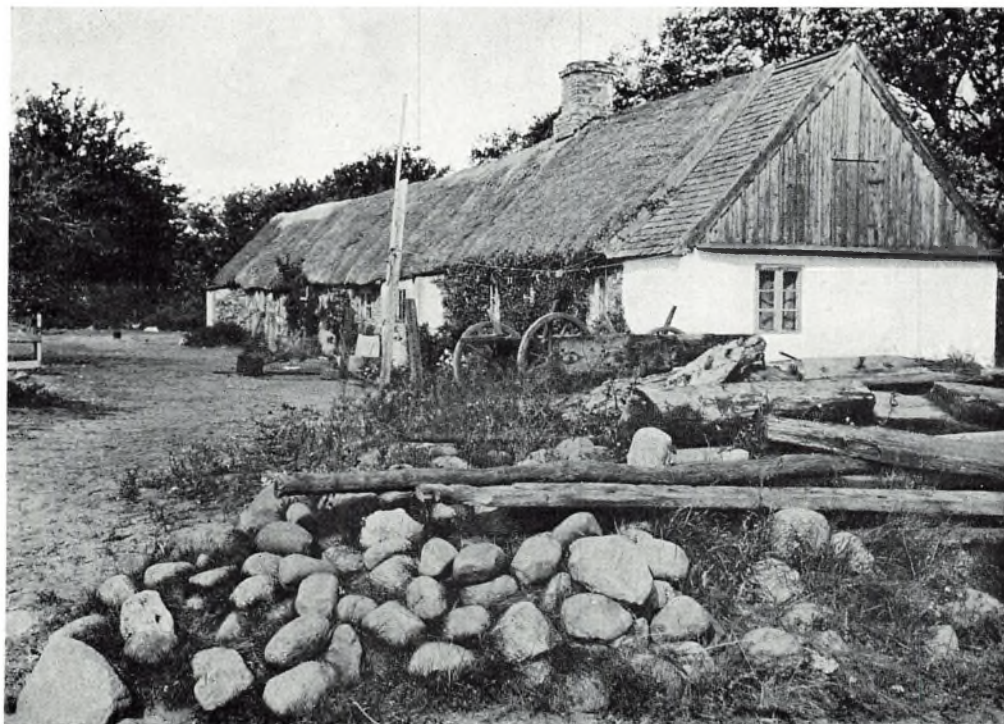
ANHOLT. Bagsiden af Degns Hus i Anholt by. Beboelse, stald og lader i samme længe. (446)
