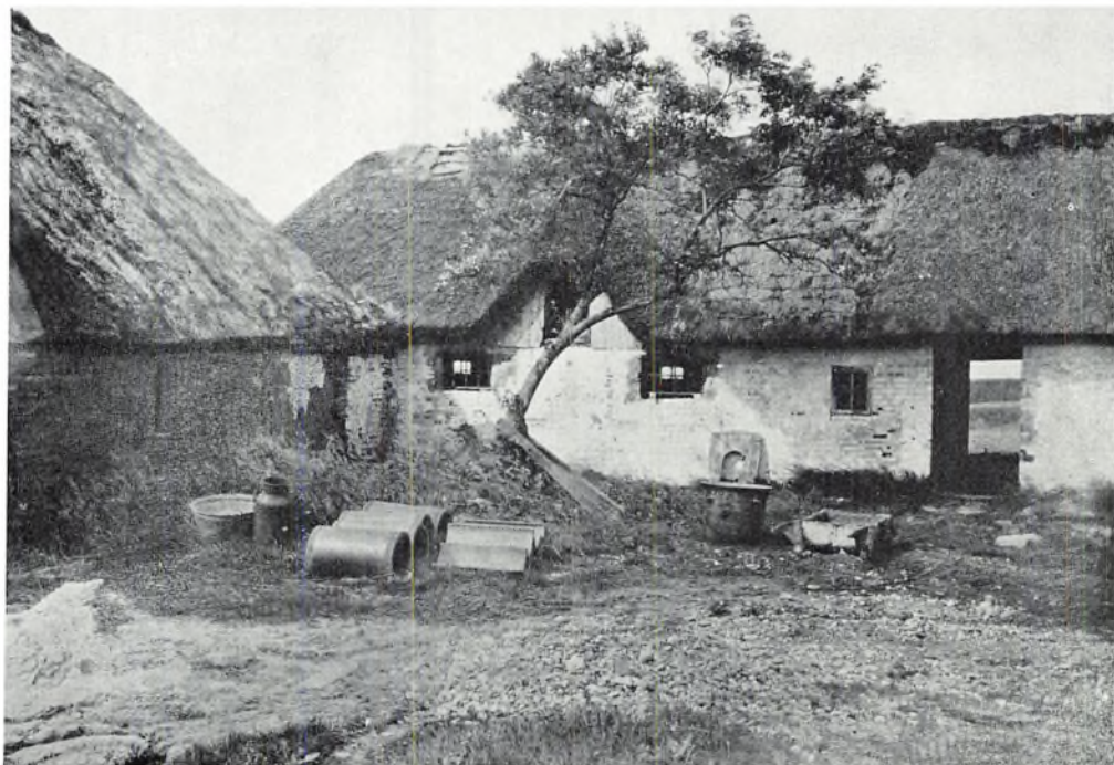
FUR. Gårdsplads med piletræ i en forfalden gård nær Faskær. (250)
