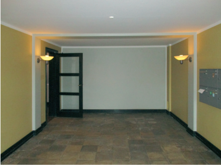
Vestibule til Sortedam Dossering 93 B. Gulve er lagt med fliser af travertin. Oprindelige bemaling, farvevalg og belysning er ikke kendt. TE foto 2021.
