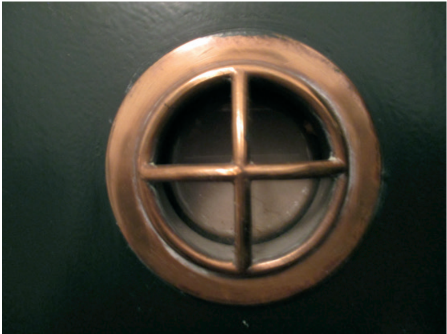
Dørspion af messing til lejlighedernes entrédøre. Design og fabrikat er ukendt. TE foto 2021.
