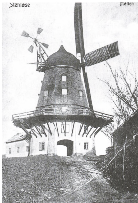
Fig. 2. Stenløse Mølle, efter alt at dømme den tidligere Nybroe Mølle fra Vesterbro, ca. 1906, forbedret ca. 1900 med vindrose og selvkrøger. Opført på stedet omkring 1861-62, ca. 25 km fra sin første placering, på et nyt muret fundament (Foto: Stenløse Lokal- arkiv).
