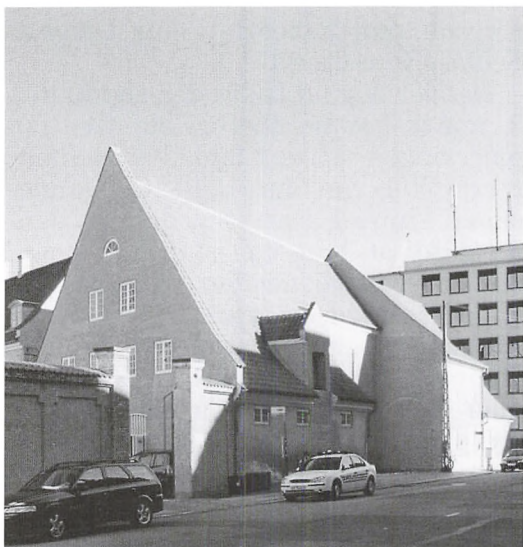
Fig. 4. Hømagasinet og Postgirobygningen set fra Vester Voldgade (Foto: Peter Winge 2002).
