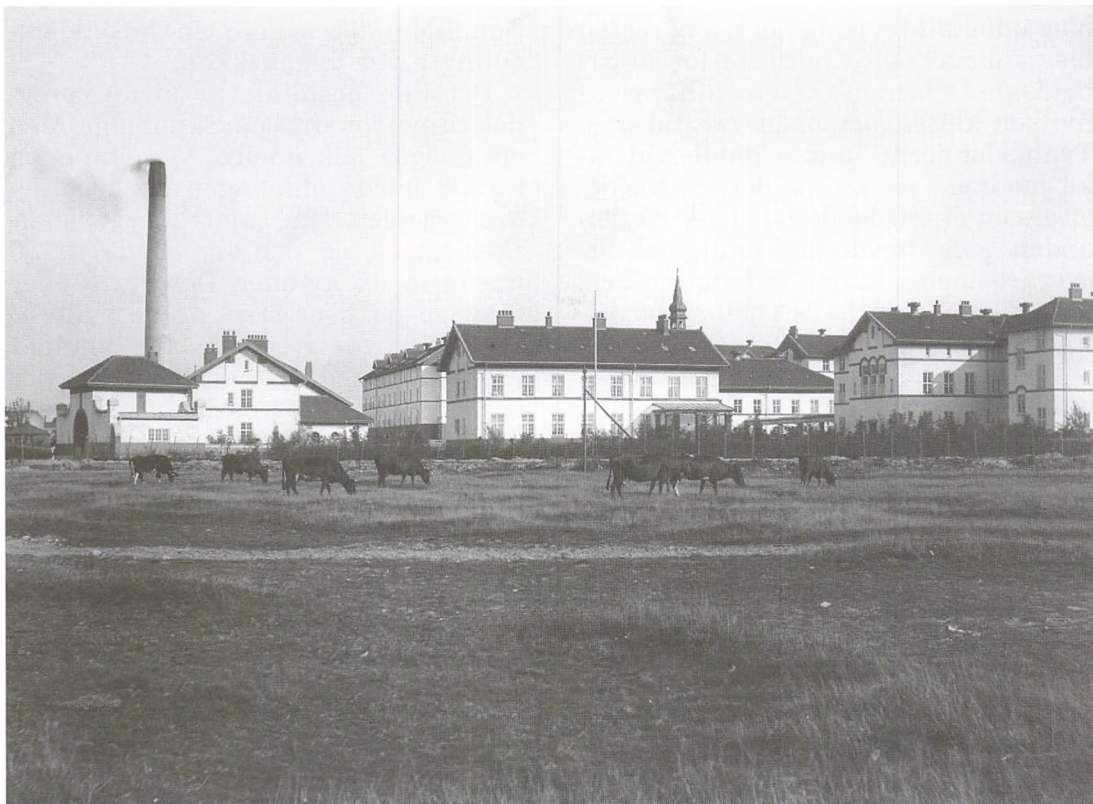
Fig. 2. Københavns nye arbejds- og tvangsarbejdsanstalt blev opført på en del af Amager Fælled (Københavns Bymuseum).
