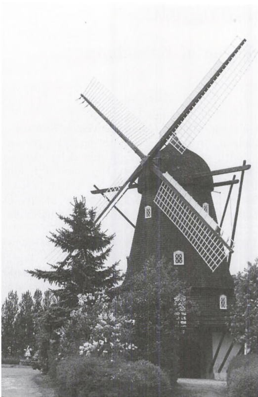
Fig. 1. Nr. Jernløse Mølle ved Holbæk. Et eksempel på en stor hollandsk mølle uden selvkrøger. Hatten drejes manuelt ved hjælp af den kraftige bjælkekonstruktion (svansen), som her ses ført ned til galleriet, hvor man med et spil manuelt kan trække i den og derved dreje hatten. Denne mølle udflyttedes ca.1885 fra sin oprindelige placering på Helters Bastion (omtrent hvor Paladsteateret nu ligger) og genopførtes i Nr. Jernløse (Foto: Nils Erik Andersen).
