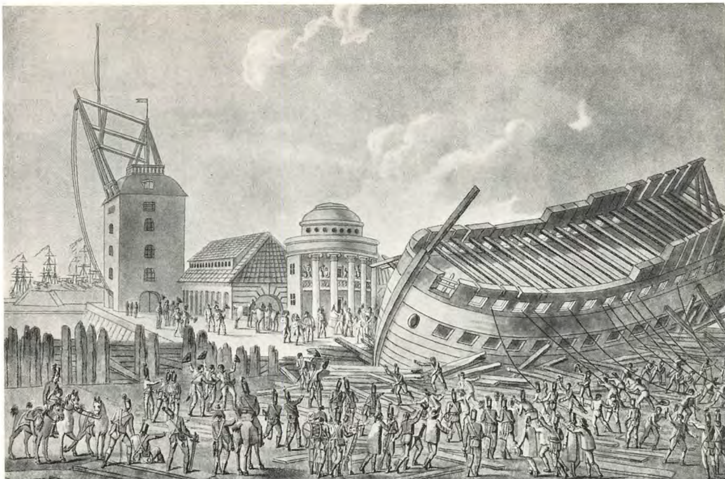
Englændernes sidste Daad, hedder ovenstaaende Billede, et Stik af G. Haas. Det stammer fra 1807, da Erobrerne efter ved Byens Bombardement at have fremtvunget Kapitulationen, ikke blot bortførte hele den danske Flaade, men ogsaa ødelagde de Skibe, der var under Bygning paa Holmen. Man ser iøvrigt paa Billedet Nyholms Kran, samt Jardins Pavillon.
