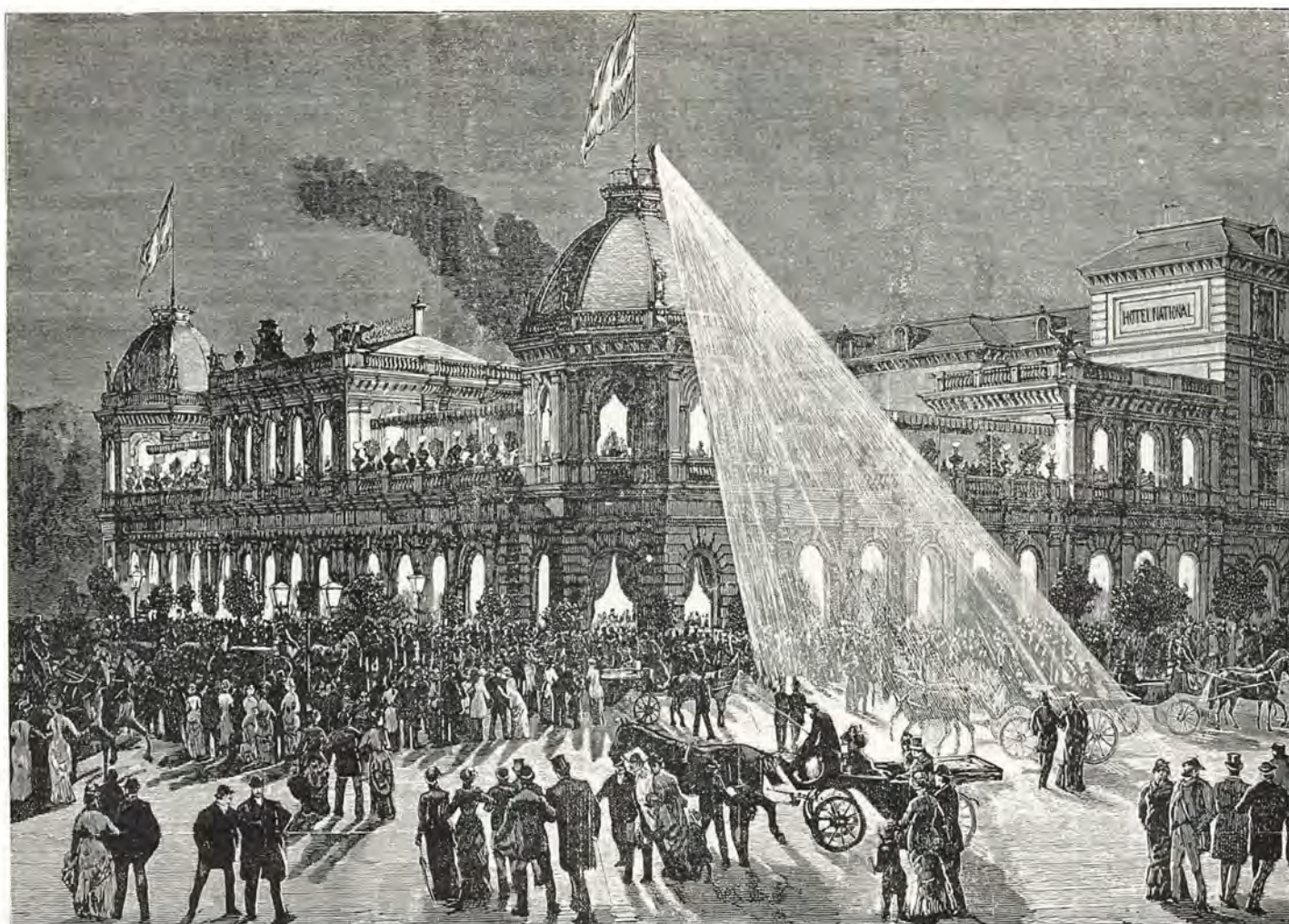
National i Festbelysning paa et Tidspunkt, da det „hvide Lys“ endnu betragtedes som Luksus og nærmest anvendtes som Illumination. Først 1894 fik København sit første, kommunale Elektricitetsværk. (Træsnit i Ill. Tidende 1882).
