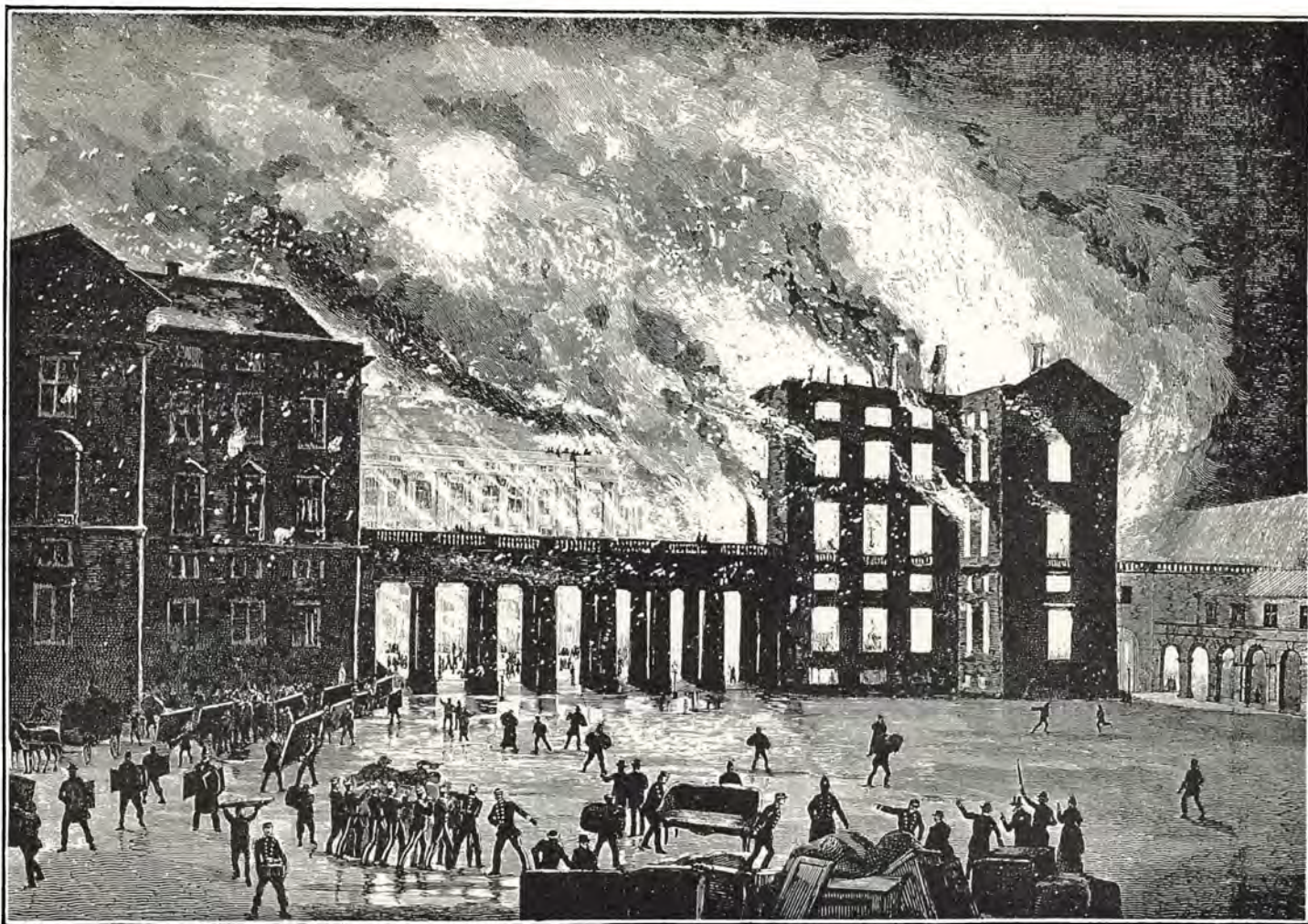
Christiansborg Slots Brand, set fra Ridebanen. (Træsnit i Ill. Tidende 1884–85 efter Tegning af Knud Gamborg). Trods Brandmure og Jerndøre var ogsaa det andet Christiansborg en brandfarlig Bygning med talrige bræddeklædte Hulrum og Kanaler, Omstændigheder, der var Bygningstilsynet bekendt, men man var paa Grund af de store Omkostninger vejet tilbage fra at gennemføre de nødvendige Sikkerhedsforanstaltninger! Den 3. Oktober 1884 indtraf Katastrofen, og efter tre Timer var Situationen, som Billedet viser.
