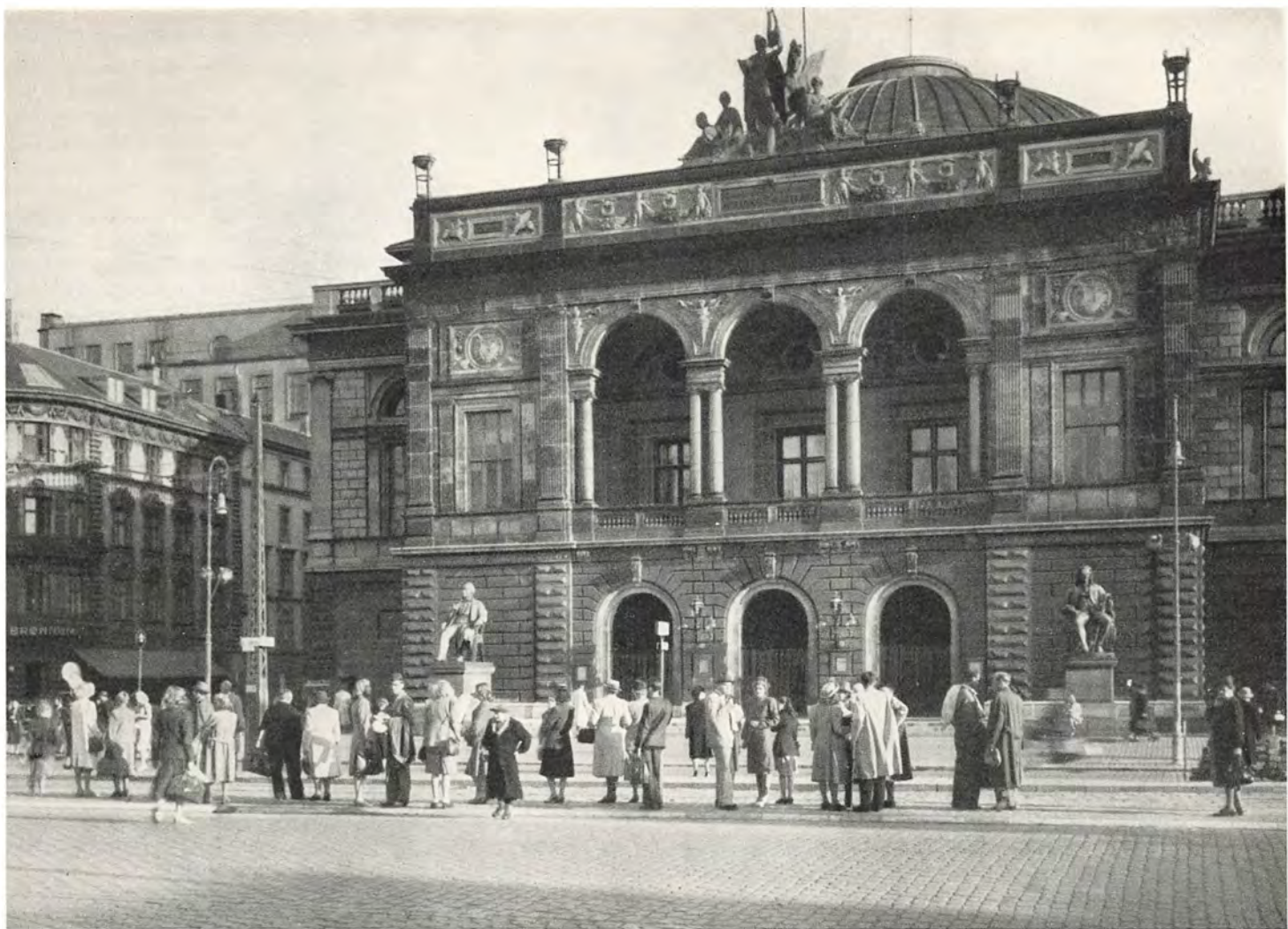
Det kgl. Teater, set fra Kongens Nytorv. (Fot. 1948, København Før og Nu).
