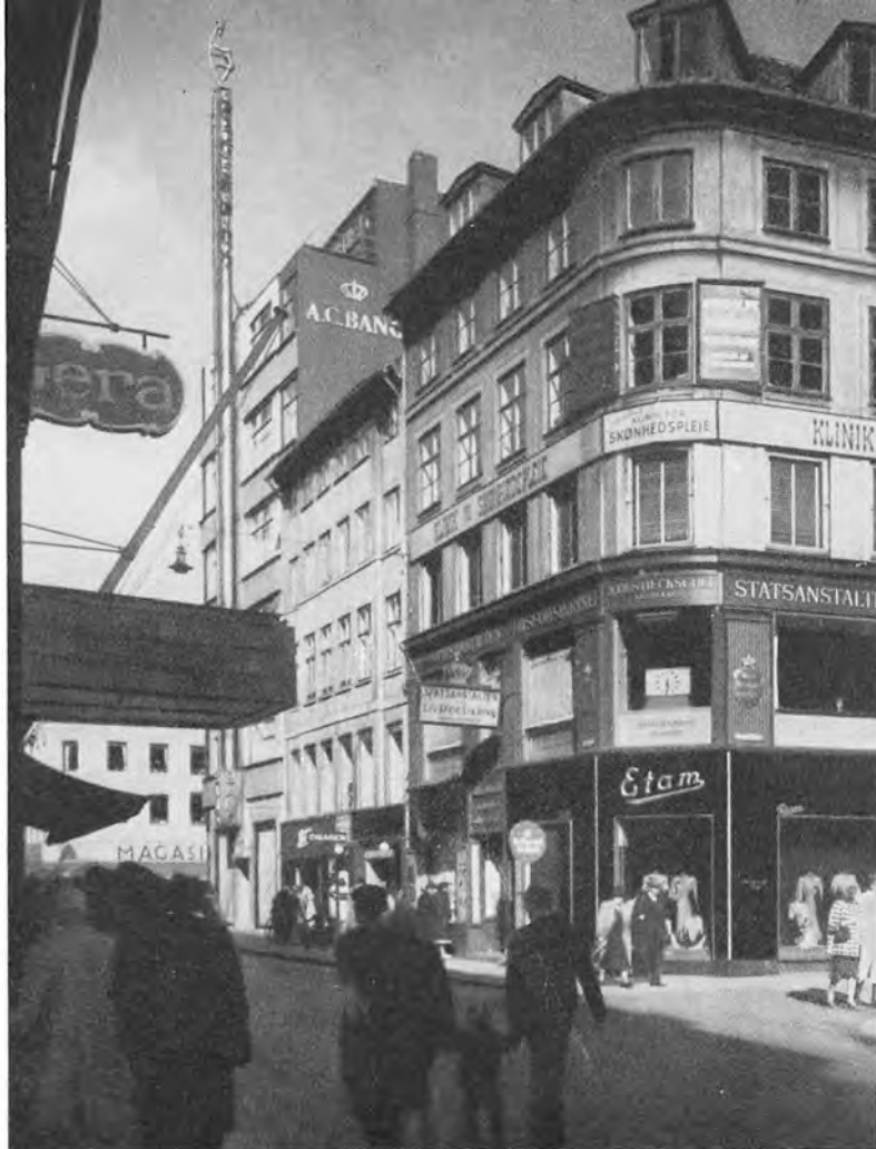
Herover: Østergade 35-27 set mod Magasins Torv med det gamle Halmstræde til højre. (Fot. 1948, København Før og Nu).
