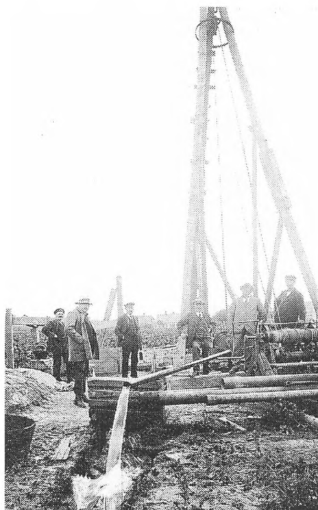
Sammen med Holeby Dieselmotorfabrik blev der foretaget en vandboring, hvorved dieselmotorfabrikken og Holebygård var de første i Holeby, der fik indlagt vand. Valdemar ses foran masten i midten af billedet
