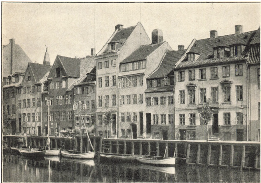
Afb. 49. Parti fra Overgaden o. Vandet. Nr. 14—26.
