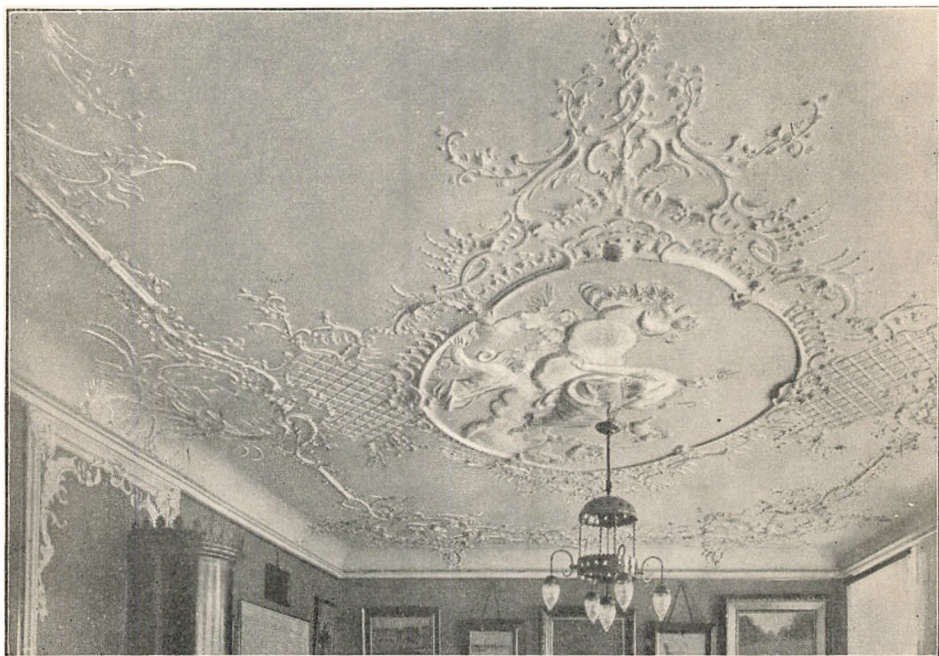
Afb. 31. Stukloft i Strandgade 46.
