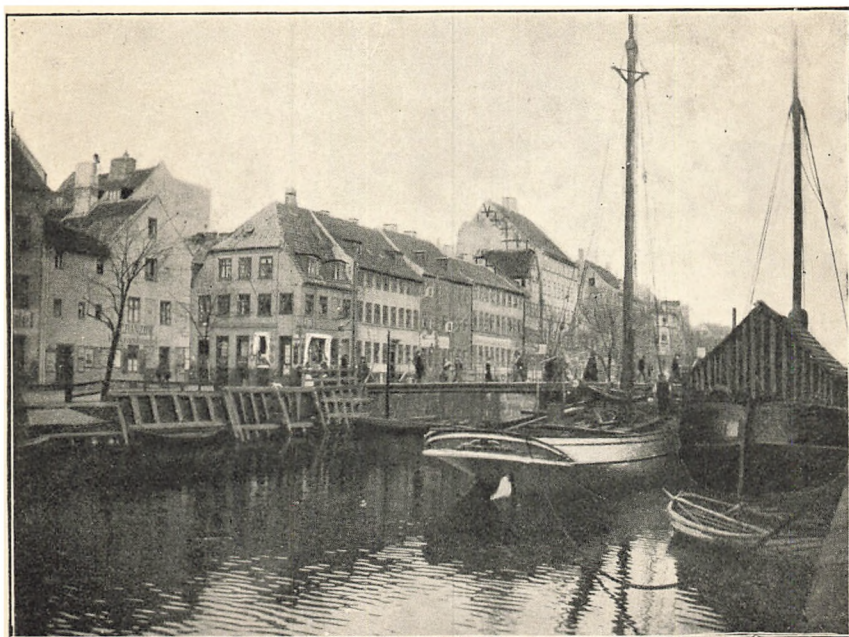
Afb. 61. Kanalen med Udsigt til Overgaden n. Vandet. G. GROVE fot.
