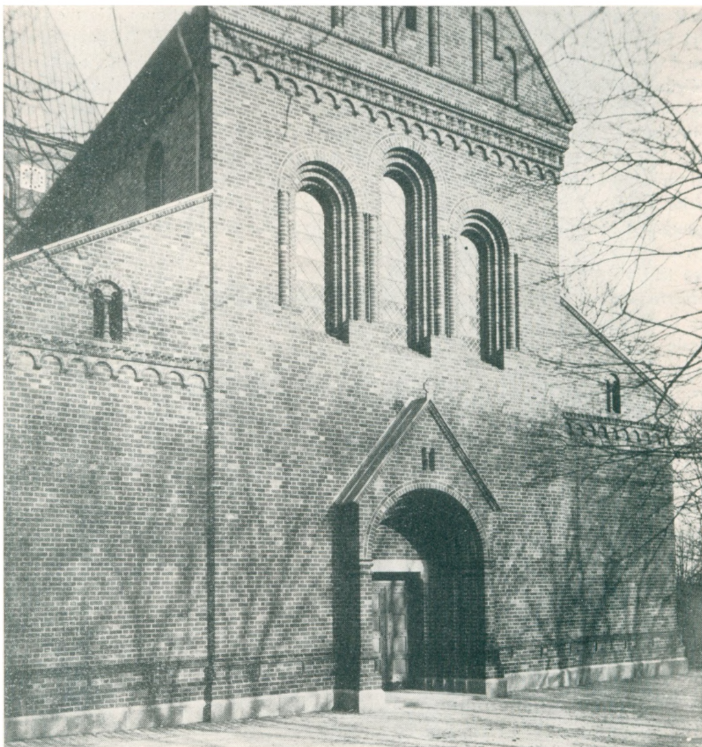
Sct. Bendts Kirke efter Restaureringen.
