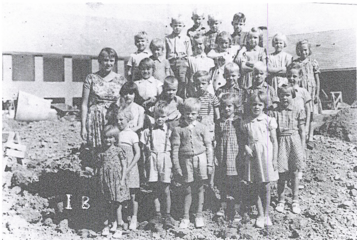
Nivå Centralskole under opførelse 1956
