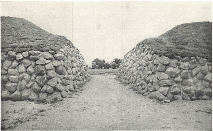
Fig. 7. Østporten, set indefra voldpladsen, efter at sidernes svære stensætninger var restaureret.
