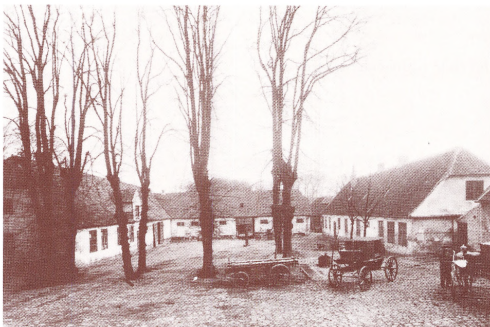
Gården til ejendommen Rolighed (Roelighed). The yard at estate Rolighed (Roelighed).
