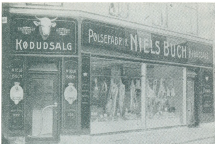
Niels Buchs Kødudsalg. Pølsefabrik. Grundlagt 1872. Udvidet 1910. Telefon 559.
