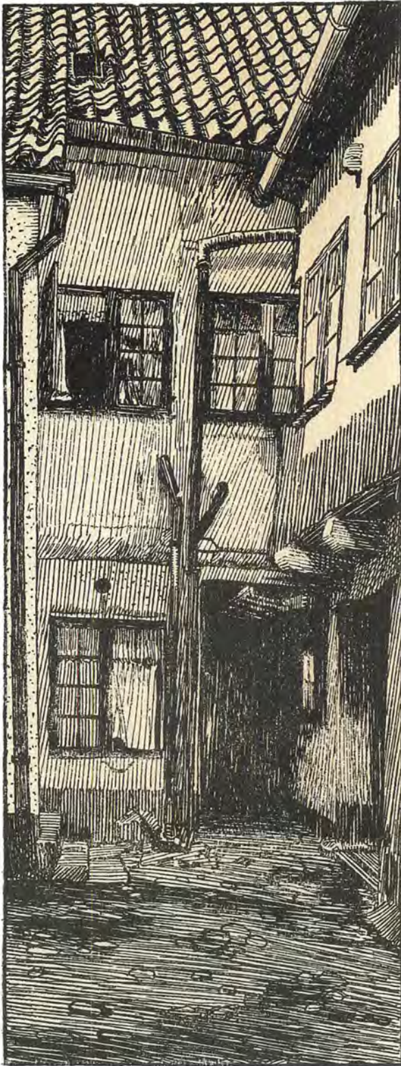
Stengade 55. Gård og mellembygning, nu nedrevet.
